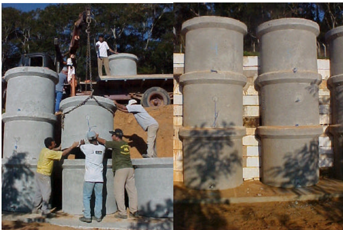
Figura 10 - Montagem dos lisímetros.
