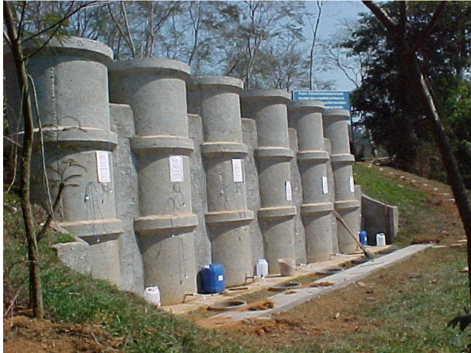
Figura 11 - Vista geral dos lisímetros.
