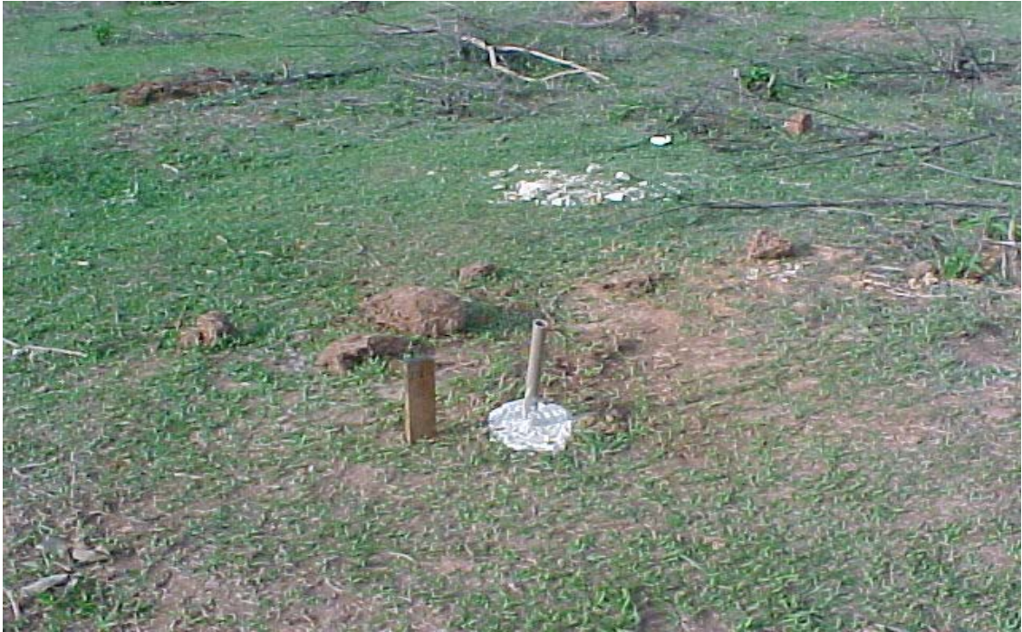
Figura 10 – Instalação de piezômetro.
