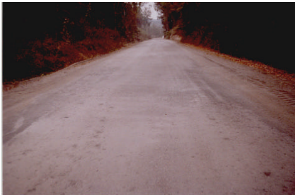
Figura 6 - Estrada imperial que liga Ouro Branco a Ouro Preto em Minas Gerais – Escória utilizada da Açominas.
