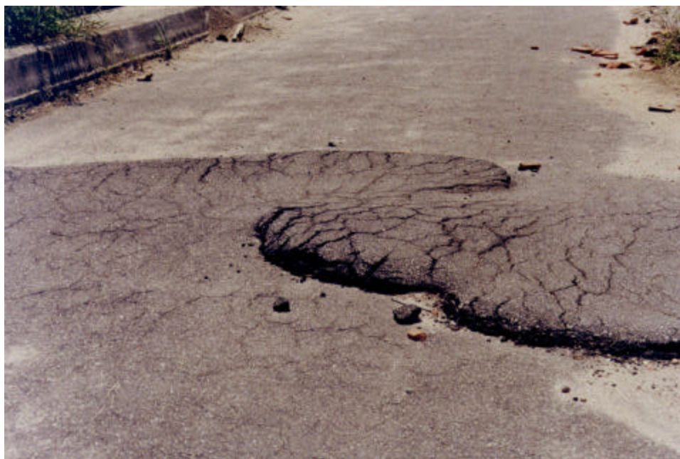
Figura 12 - "Quebra-mola" formado pela expansão da escória.
