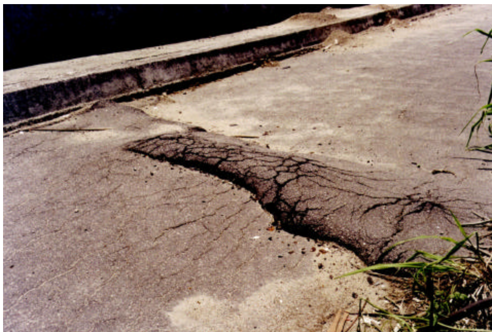
Figura 3 - Detalhe do "quebra-mola" provocado pela expansão da escória de aciaria na ciclovia da Av. Fernando Ferrari que liga Vitória-ES ao litoral norte
