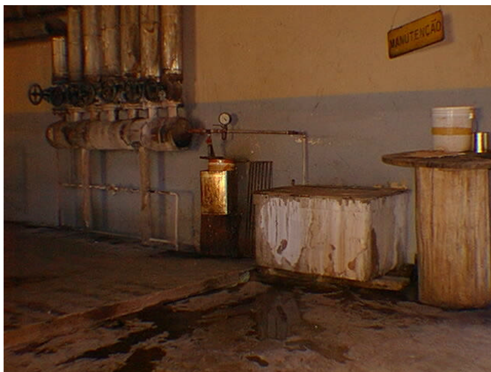
Figura 18 - Detalhe da caixa de argamassa armada onde foi acondicionada a escória e parte da ramificação da caldeira entrada do vapor.
