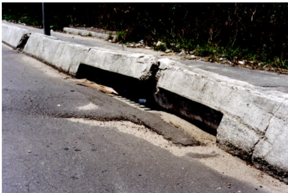
Figura 10 - Detalhe da boca de lobo-dispositivo de drenagem na Av. Fernando Ferrari (BR-101).
