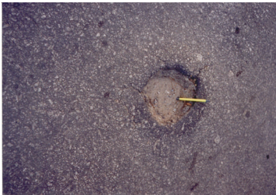
Figura 3 - Detalhe do "quebra-mola" provocado pela expansão da escória de aciaria na ciclovia da Av. Fernando Ferrari que liga Vitória-ES ao litoral norte
