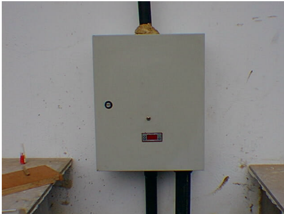
Figura 25 - Detalhe do controlador de temperatura do ensaio
