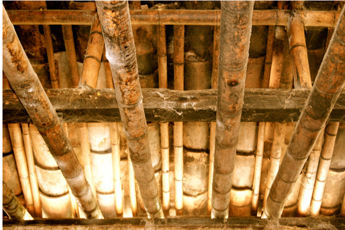
Figura 25 - Estructura de techo en casa antigua
