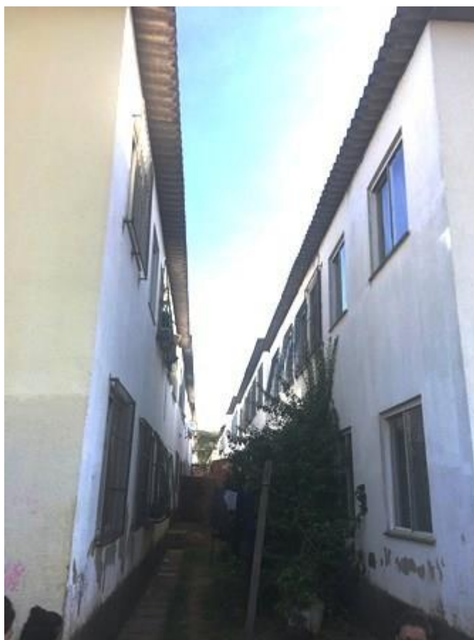
Figura 66 - Detalhe do afastamento existente entre as edificações
