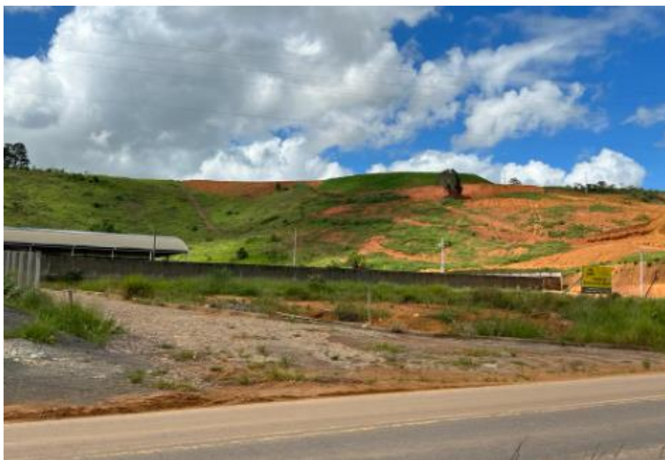
Figura 59 – Terraplanagem realizada as margens da BR 356 em frente ao lado do CRNM
