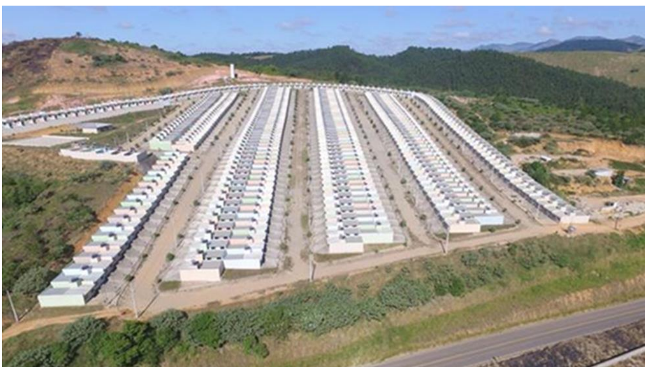
Figura 73 - Imagem do RVII na conclusão das obras – 2016
