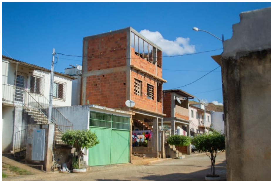
Figura 117 – Ampliações em edificação do CRNM
