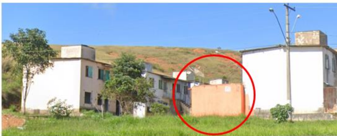
Figura 61 – Modificações e acréscimos executados nas edificações originais
