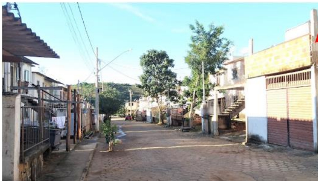
Figura 72 - Imagem de acréscimo realizado da parte frontal da edificação
