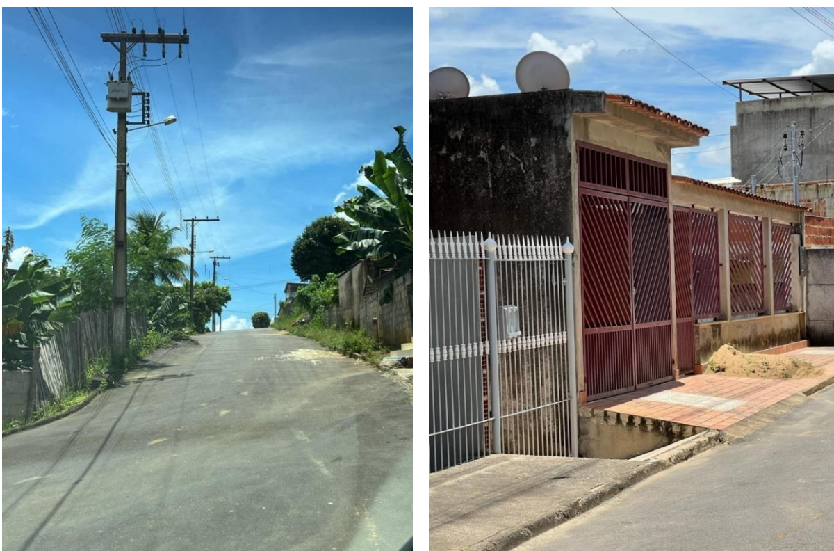
Figura 42 – Vias com ausência de passeio e com obstáculo construtivo na vila
