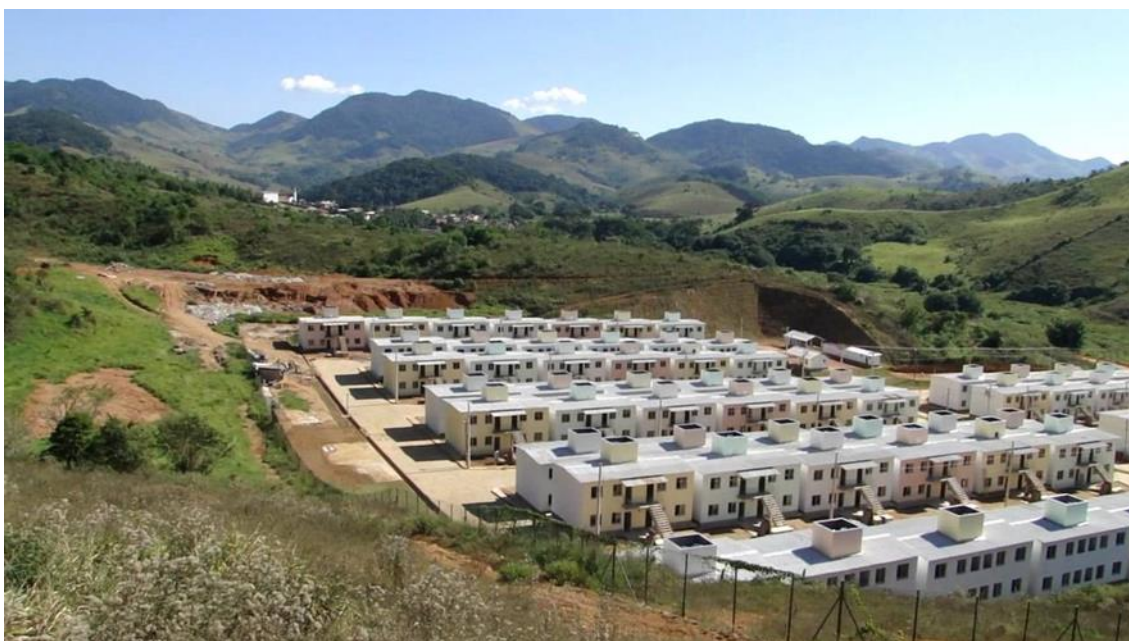
Figura 55 – Condomínio Popular Nova Muriaé, na conclusão das obras 2011
