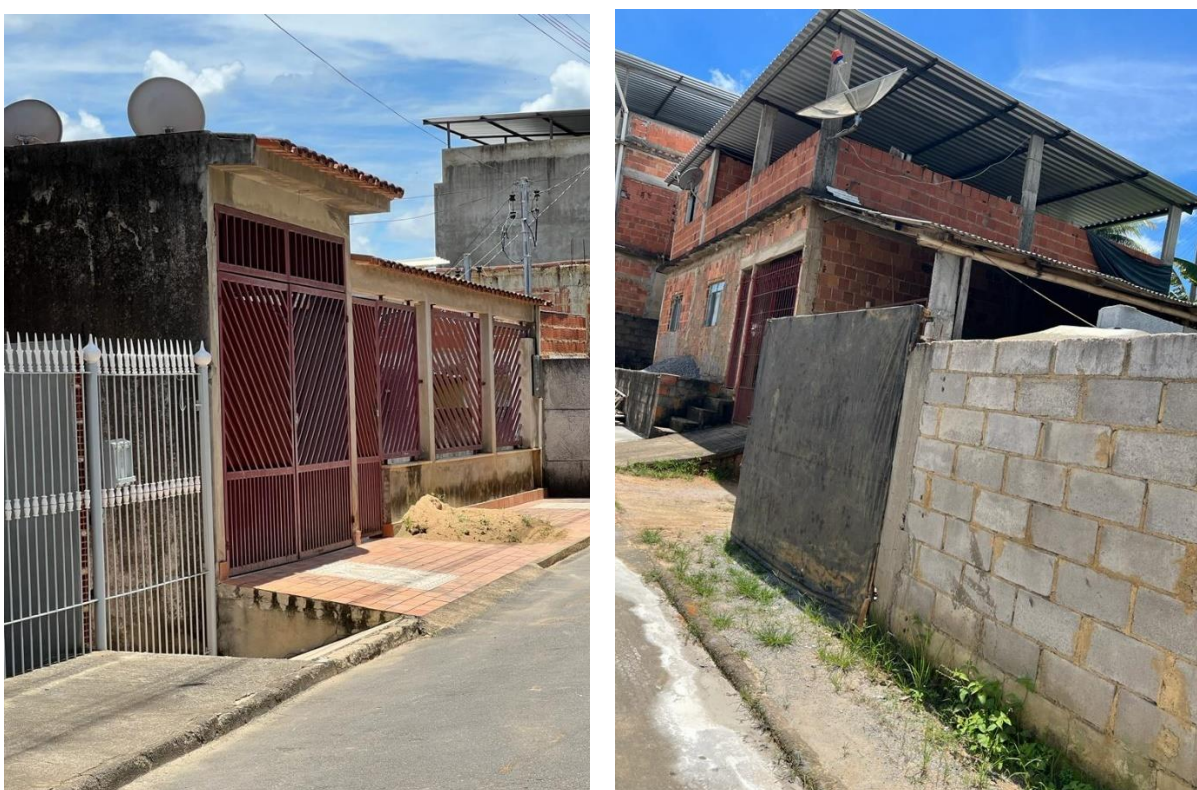
Figura 128 - Obstáculos nas calçadas em casa da vila do Distrito do Vermelho
