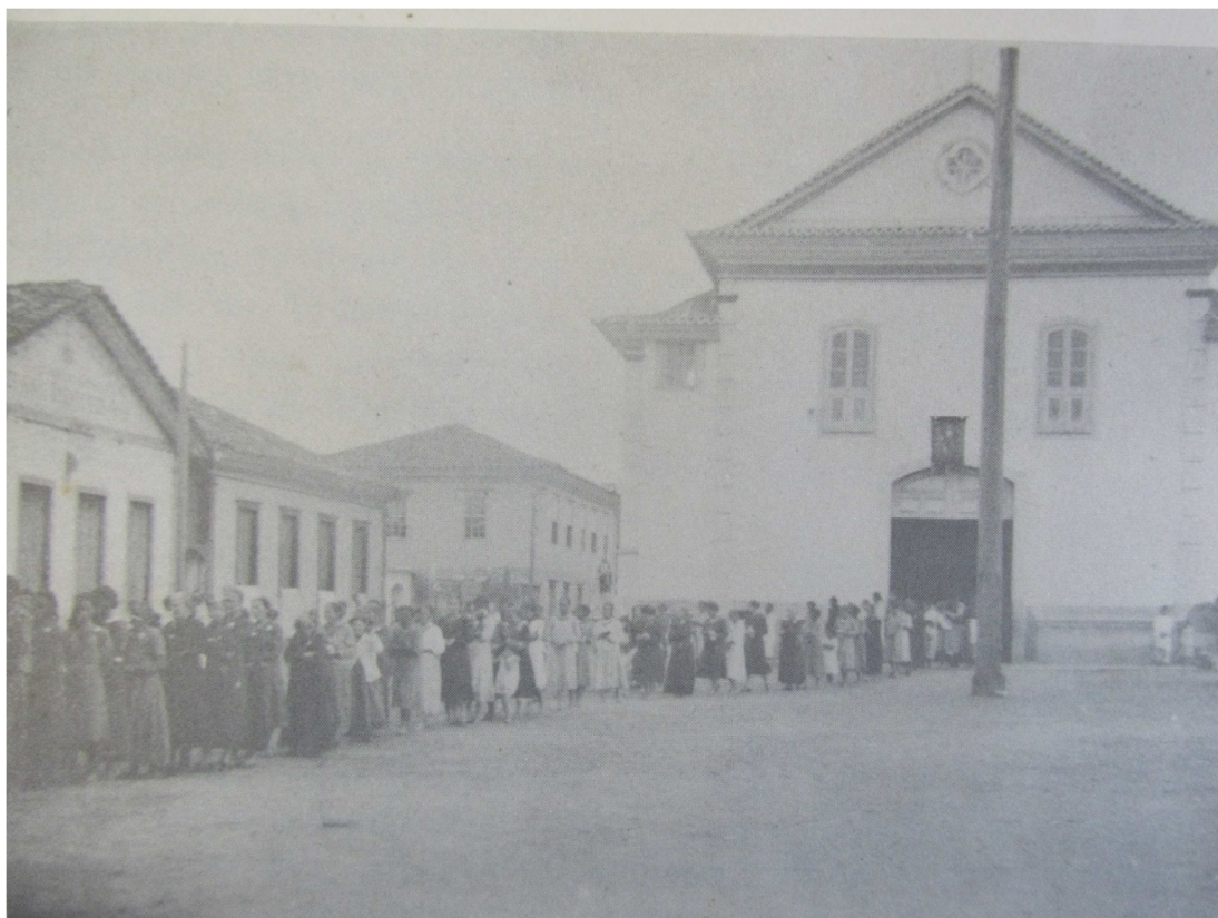
Figura 2 - Capela de Santo Antônio de Calambau em 1775
