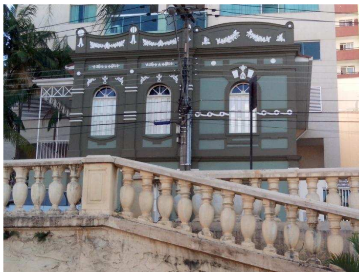
Imagem 25 - Casa Cora Bolívar e Balaústre.
