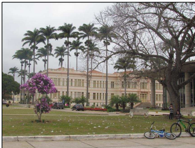
Figura 24: vista parcial do campus da UFV com destaque, ao fundo, para o Edifício Arthur da Silva Bernardes – “Bernardão”. Acervo pessoal Isabela Guerra e Walkiria Martins. 05/07/15.
