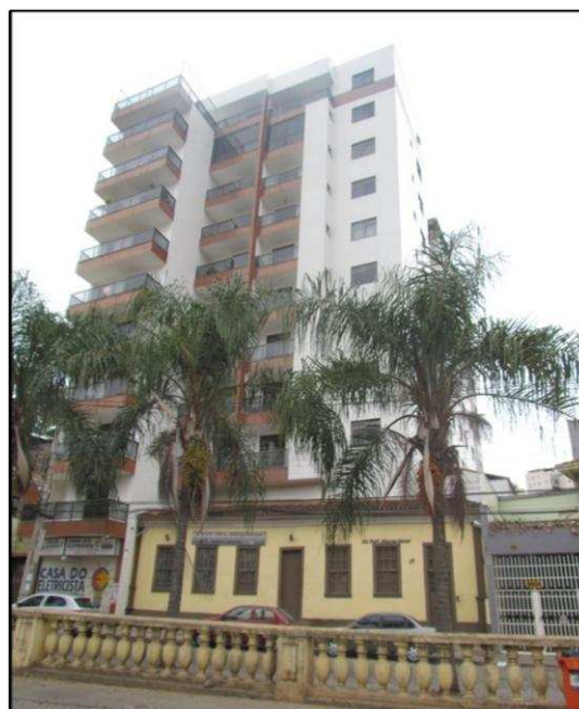
Figura 12: fachada preservada do primeiro hospital da cidade, localizado à Avenida Bueno Brandão, Viçosa – MG. Acervo particular Isabela Guerra e Walkiria Martins. 05/07/15.
