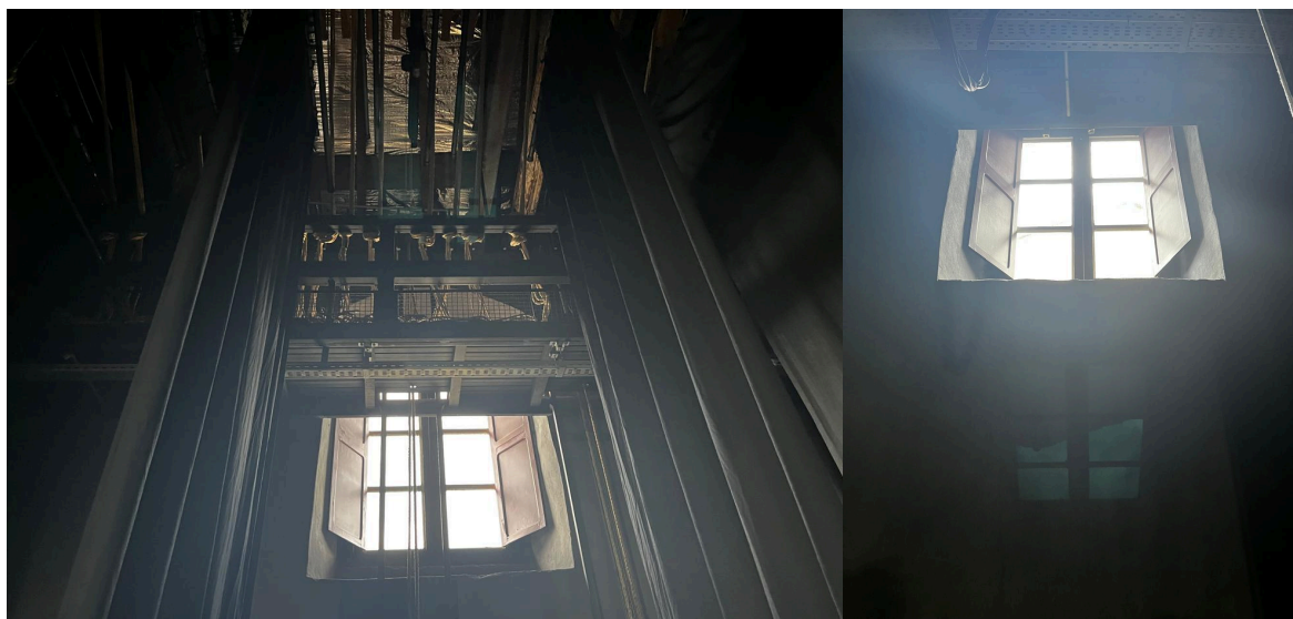
Figura 86 e 87. Janelas laterais do palco do Teatro Municipal - Casa da Ópera de Ouro Preto.
