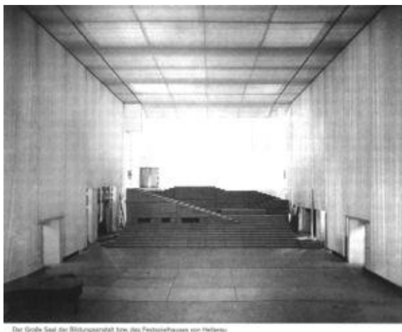
Figura 35. Salão principal do Festspielhaus, mostrando o sistema de iluminação difusa, 1912.
