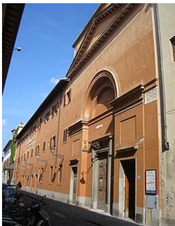
Figura 17. Fachada do Teatro della Pergola.
