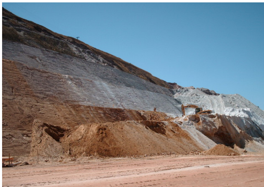
Foto 3.5 - Conformação de face de talude em quartzito na Mina Capitão do Mato (24 /08/2007). Destaque para a heterogeneidade do maciço.
