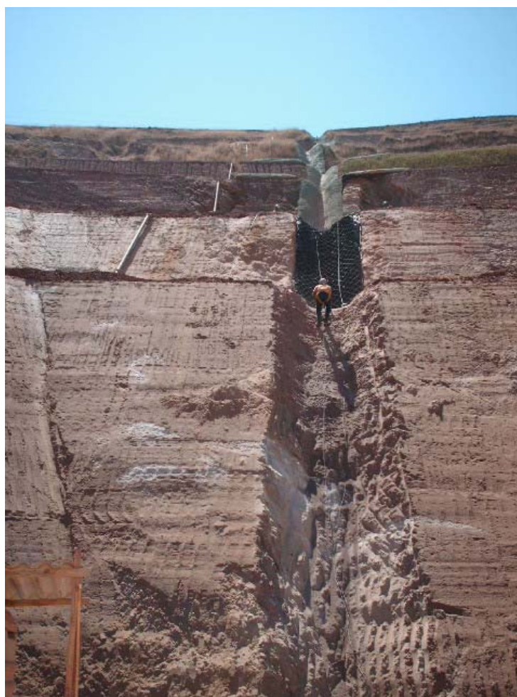
Foto 3.4 - Execução de descida de água, em talude de filito dolomítico, na Mina Capitão do Mato (24 /08/2007).
