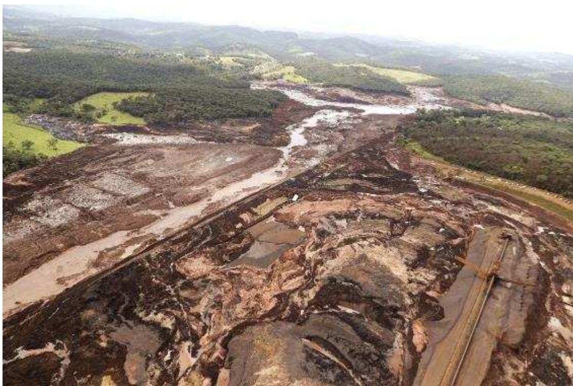
Figura 25. Lama do rompimento da barragem de rejeitos da empresa Vale S.A. em Brumadinho/ MG.
