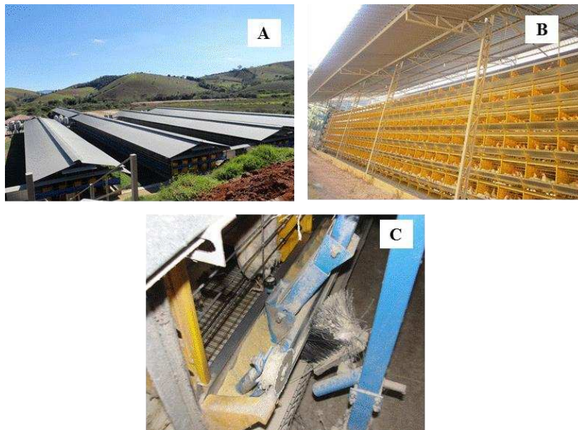
Figura 3.2. Aviários abertos com ventilação natural, instalações típicas da indústria brasileira: A) Vista das instalações e modelo de cobertura; B) Vista dos sistemas verticais de criação em baterias de gaiolas; C) Detalhe do sistema de distribuição de ração.
