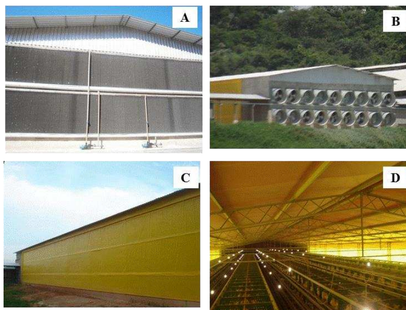
Figura 4.3. Aviários Fechados com Sistema de Ventilação por Pressão Negativa associada a sistema de resfriamento adiabático por placas evaporativas Instalações avícolas: A) Vista externa do sistema de resfriamento adiabático evaporativo B) Vista externa do grupo de exaustores; C) Detalhe dos fechamentos laterais, através de cortinas; D) Detalhe do interior da instalação, com destaque para o material isolante na cobertura e vista superior das baterias de gaiolas.
