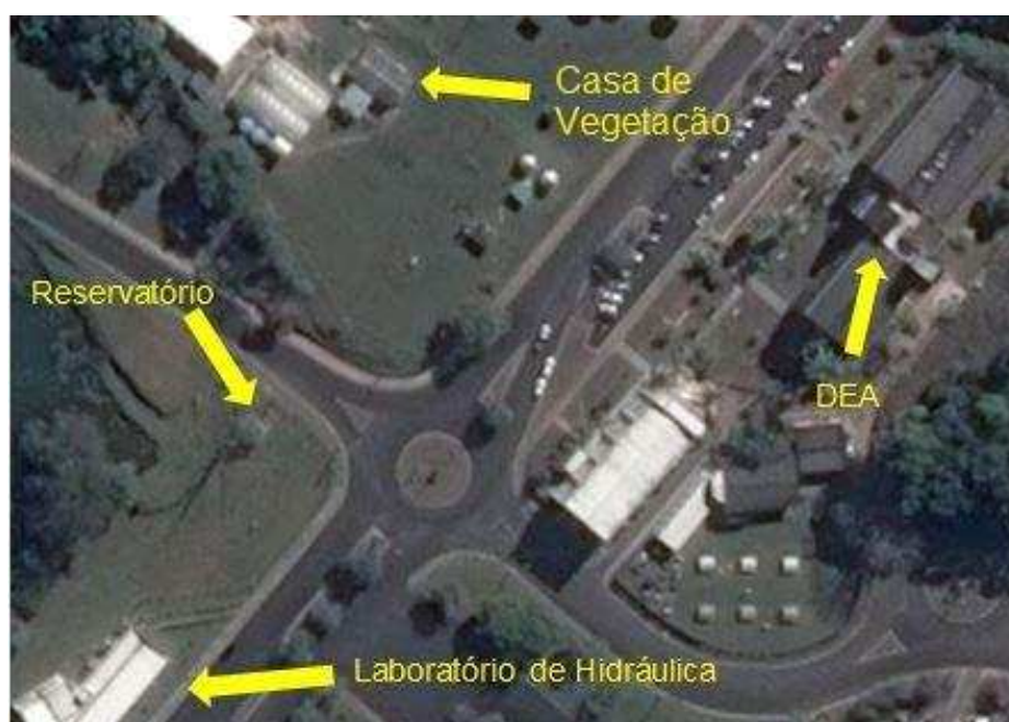
Figura 2 – Imagem aérea do local em que foi instalado o experimento, com detalhe das principais instalações.
