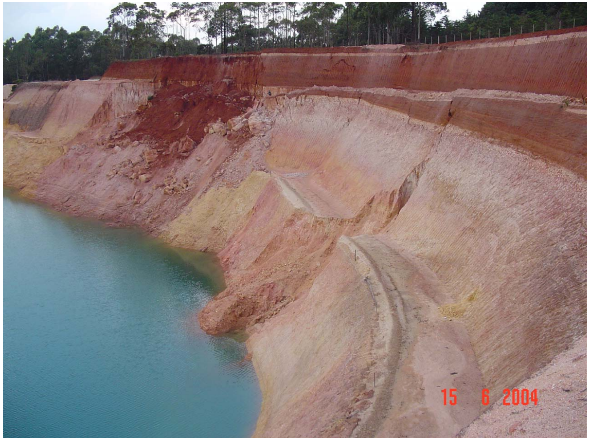
Figura 1.1 – Talude rompido localizado nas proximidades da Mina de Capão Xavier
