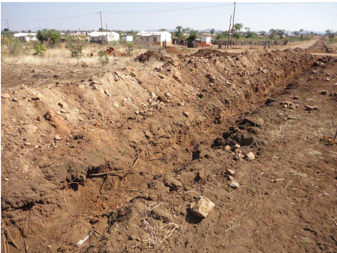
Foto 16: Obra de encanamento da água, Cateme. Ana Carolina Rodrigues -04/06/2013.
