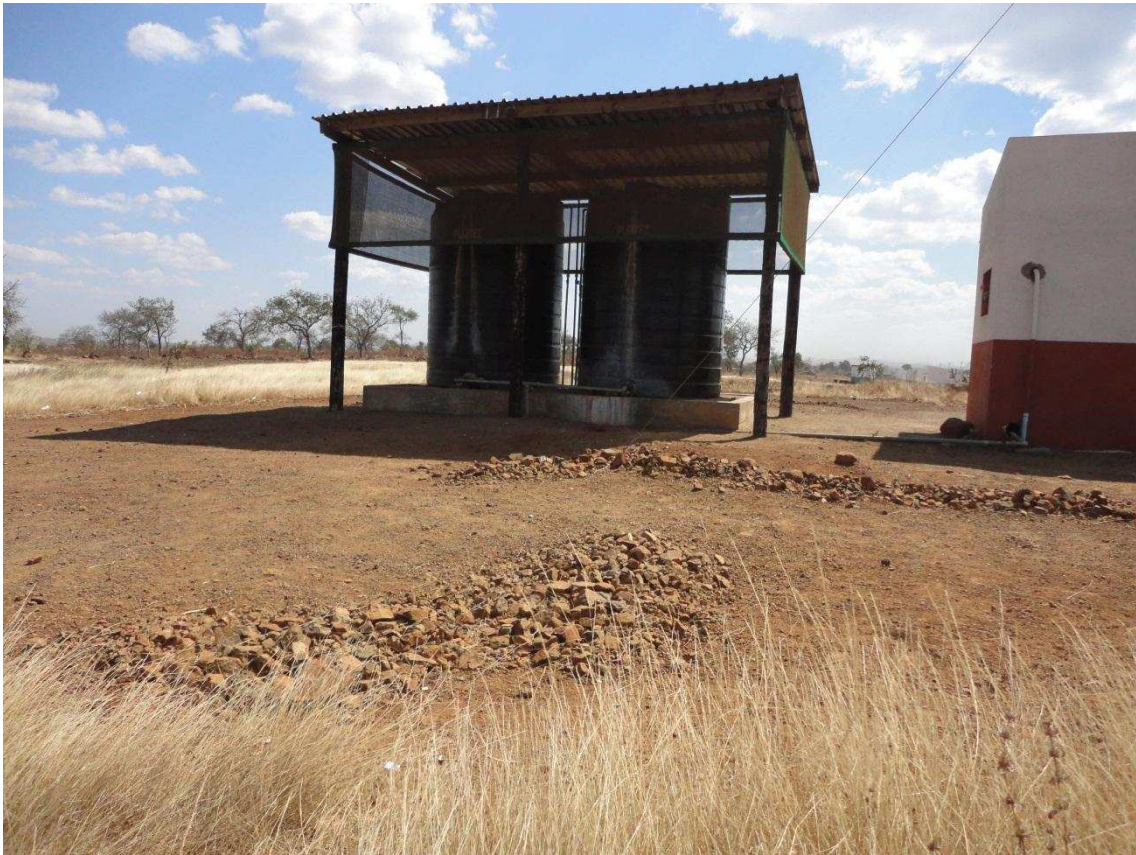
Foto 15: Reservatórios de água, Cateme. Ana Carolina Rodrigues -04/06/2013.
