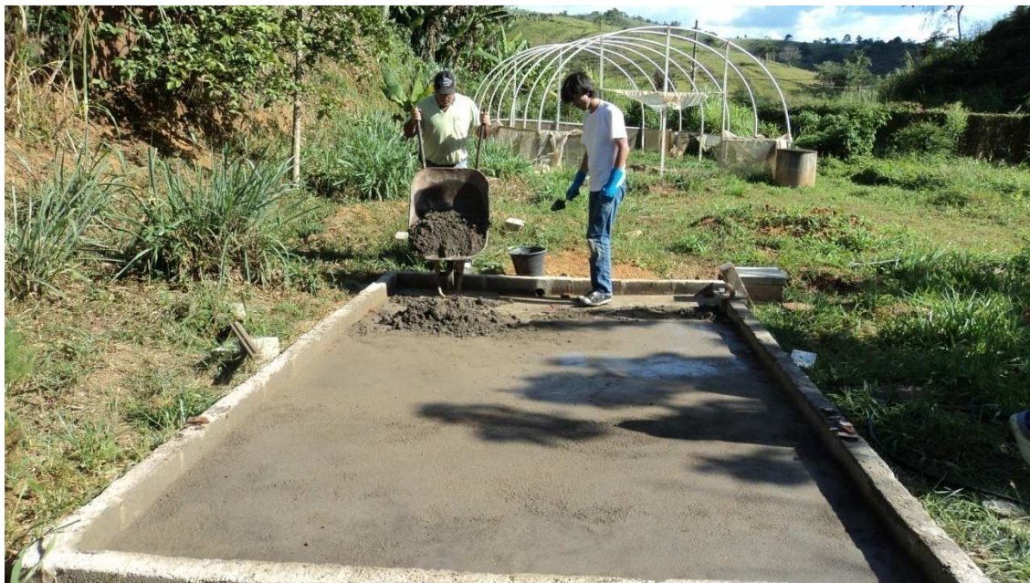
Figura 23. Execução de camada de argamassa
