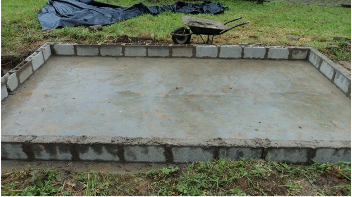
Figura 18. Contorno da base com blocos preenchidos com concreto
