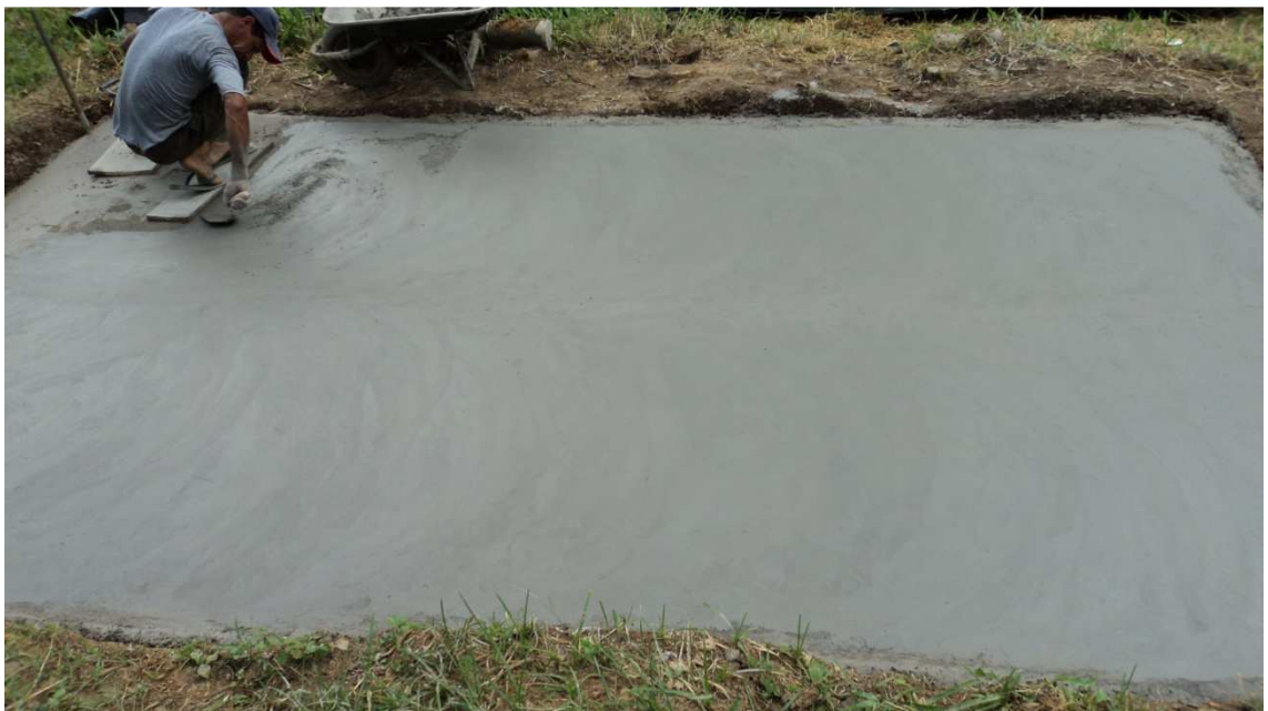
Figura 17. Base de concreto executada e “polida” com cimento
