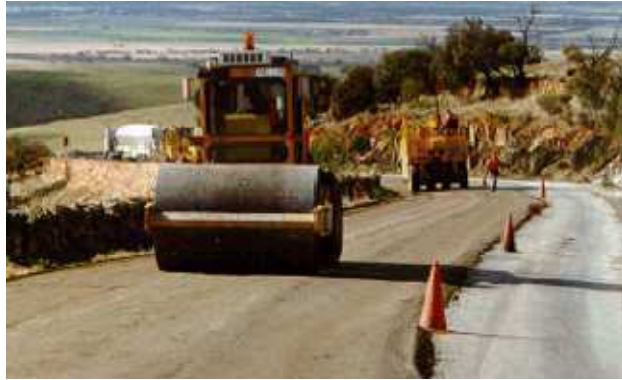
Figura 12. Execução de base estabilizada com solo-cimento
