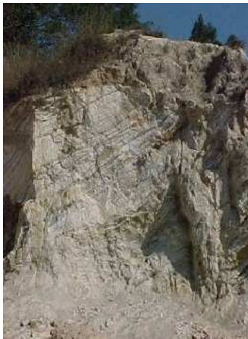
Figura 14. Talude na região da Vila Secundino - UFV
