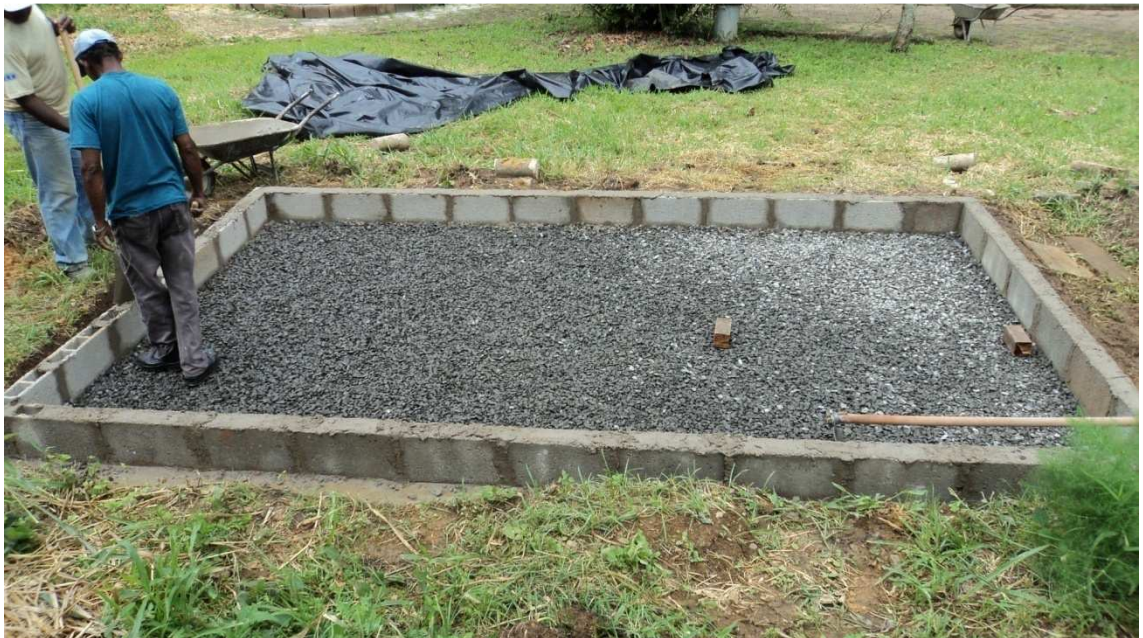
Figura 19. Execução de camada de brita 2
