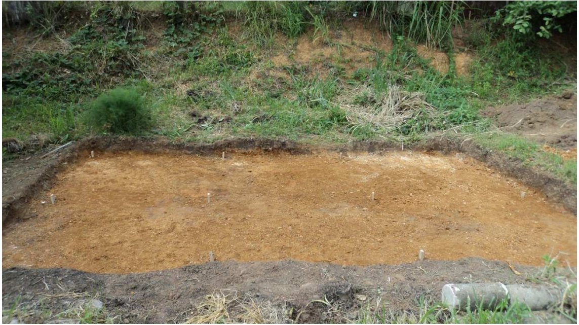
Figura 16. Terreno limpo, nivelado e gabaritado para execução da base de concreto
