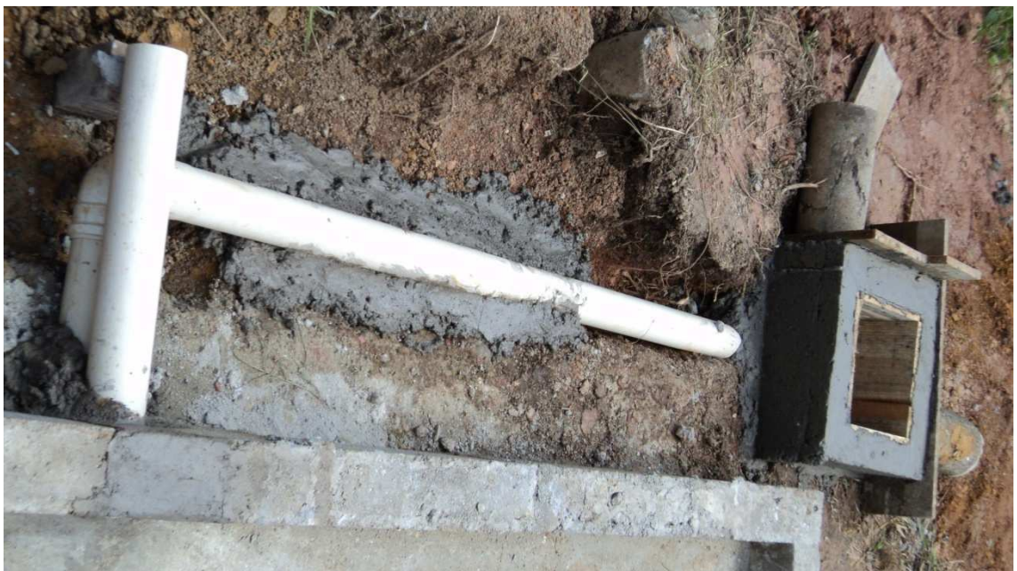
Figura 22. Tubos de coleta de águas pluviais do pátio e cama de brita
