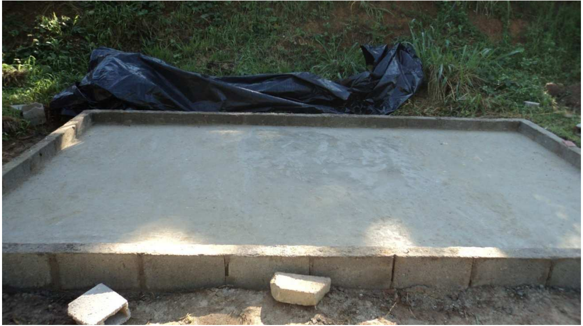
Figura 21. Pátio de solo-cimento ao término da execução
