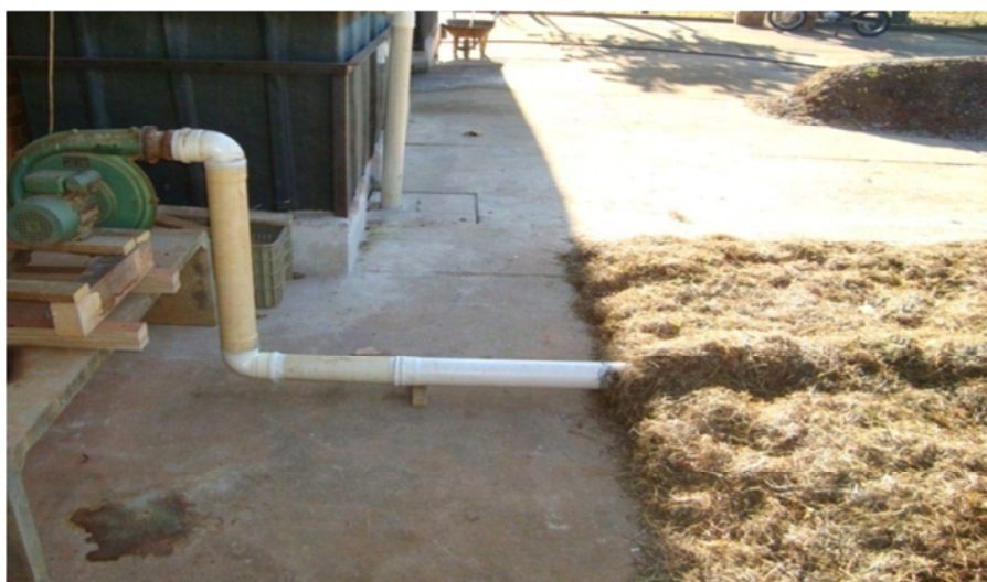
Figura 6 – Conjunto ventilador e tubulação recoberta por palha
