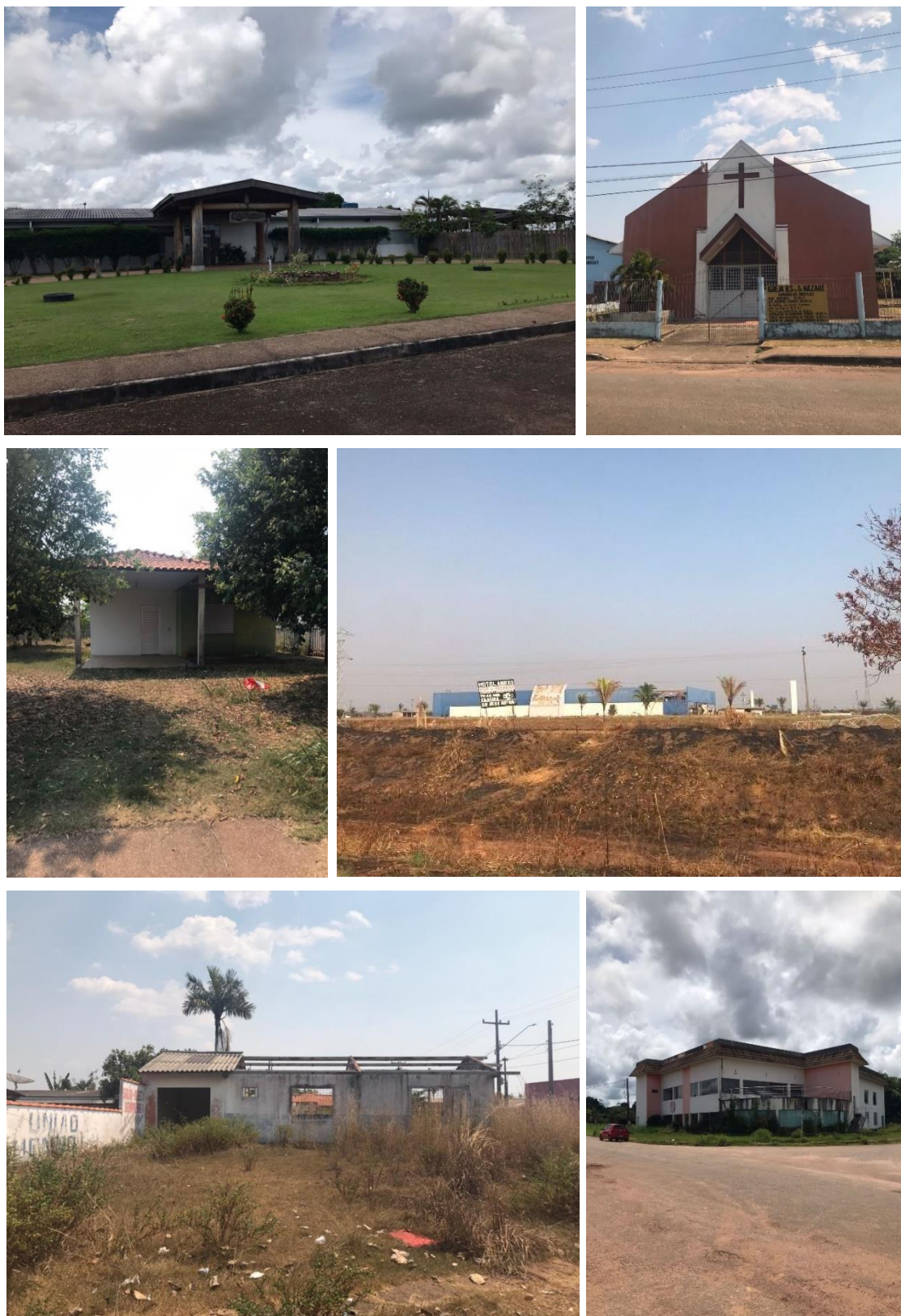
Figura 95 - Hotel Madeira Mamoré, Igreja Católica, Casa e Galpão abandonados, edificação depreedada e Prédio antiga sorveteria Dullin
