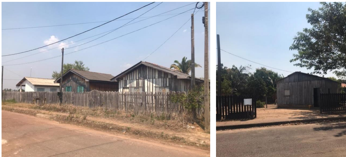
Figura 96 - Casas madeira Autoconstrução
