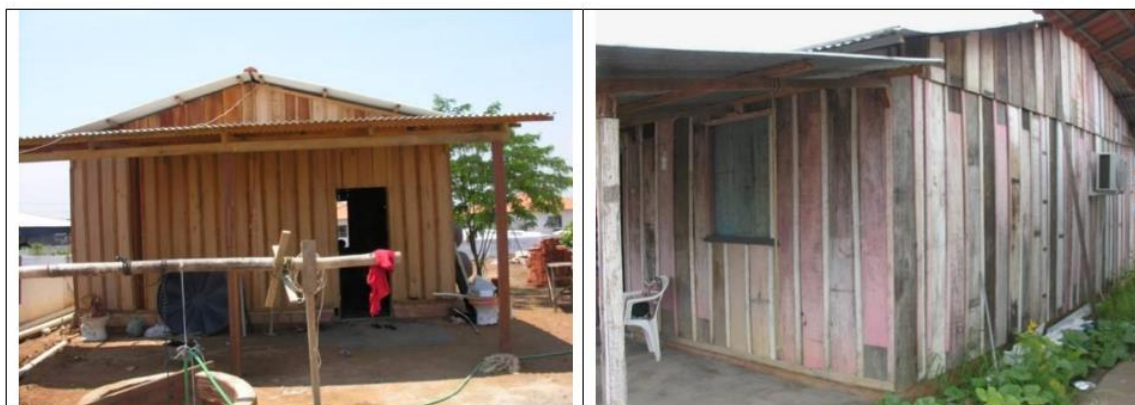
Figura 46 - Modalidade de Indenização Autoconstrução
