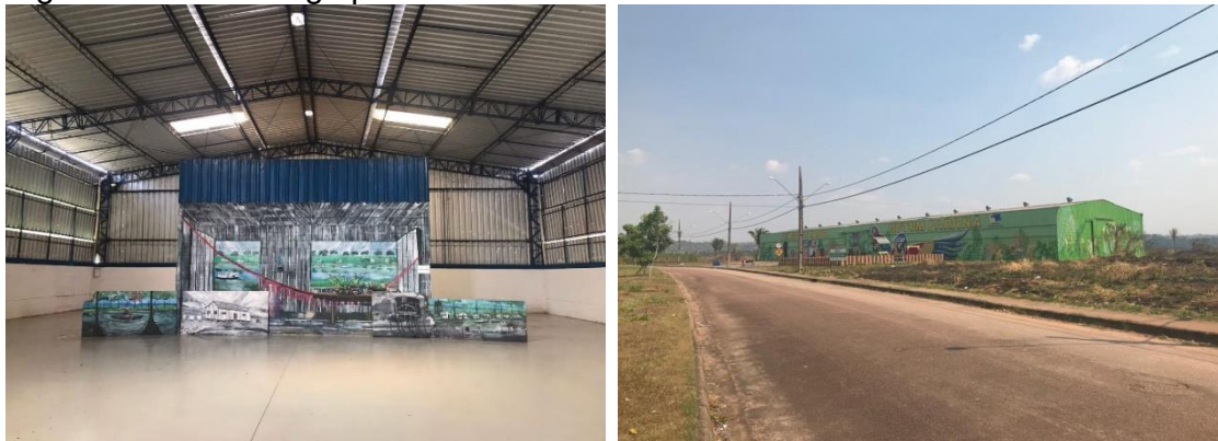
Figura 64 - Interior galpão da feira e entorno
