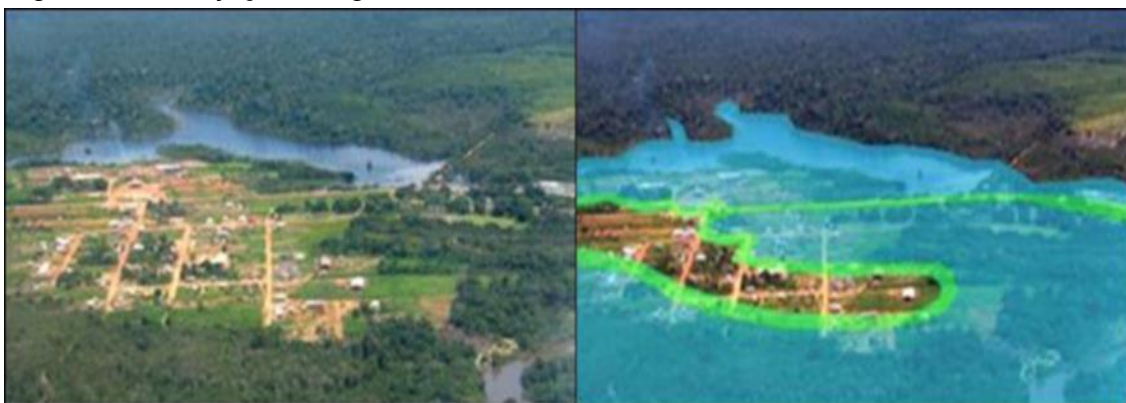
Figura 22 - Projeção Alagamento Mutum-Paraná
