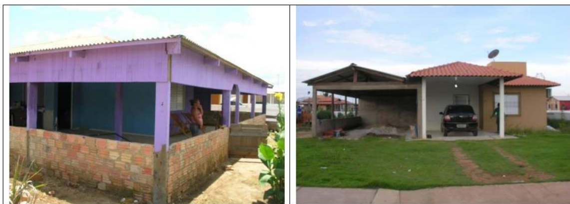
Figura 45 - Ampliação nas edificações
