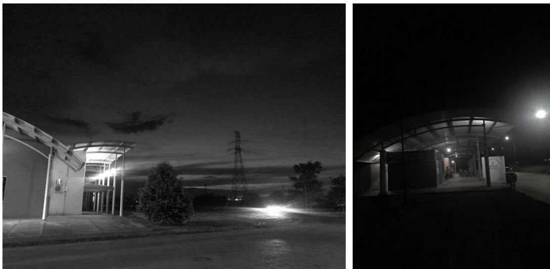
Figura 92 - Centro Comercial e Rodoviária
