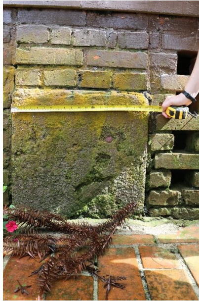
Figura 22 - Estrutura de fundação da casa 227
