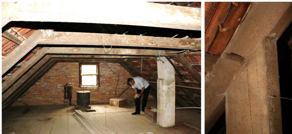
Figura 24 - Estrutura da cobertura e encaixe com pino de madeira 230
