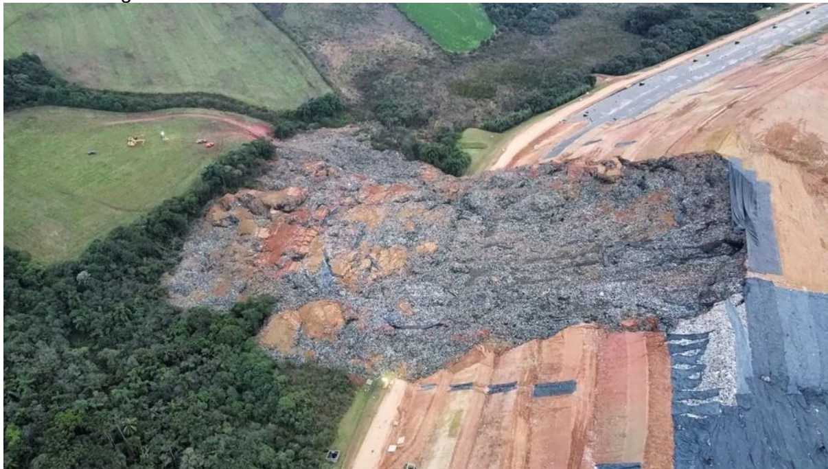
Fotografia 1 - Deslizamento no aterro sanitário de Fazenda Rio Grande-PR.
