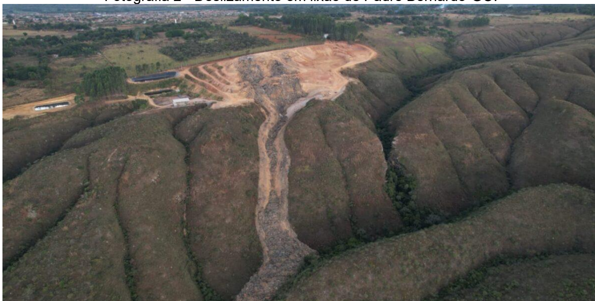
Fotografia 2 - Deslizamento em lixão de Padre Bernardo-GO.
