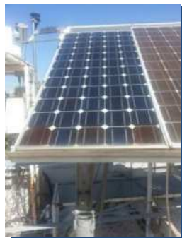
c) Pontos quentes em células quebradas ou sombreadas: altos valores da resistência série.
