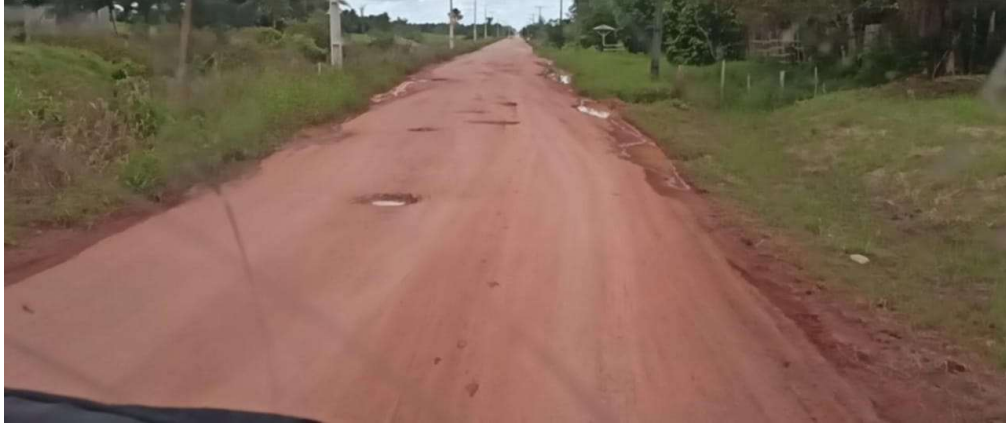
Figura 17 - Pavimentação de Ramal, no Careiro da Várzea-AM. Fonte: Acervo próprio, 2024.
