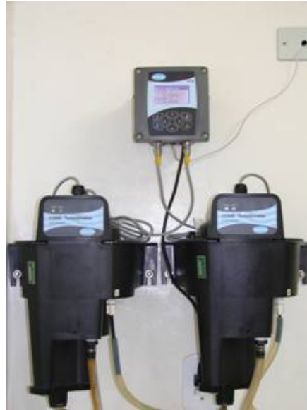
Figura 18 - Turbidímetro de processo modelo HACH 1720 E.
