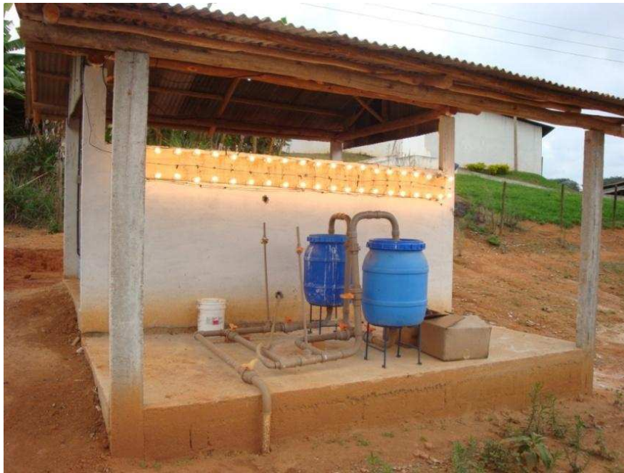
Figura 31 Vista geral do sistema de filtragem do biogás e do conjunto de lâmpadas incandescentes para consumo da energia elétrica gerada.
