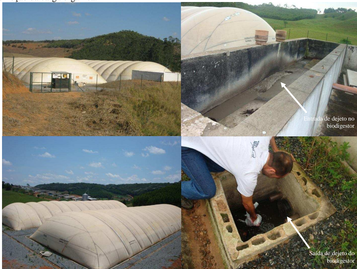
Figura 06 Vista geral do biodigestor e pontos de coletas das amostras de dejetos.
