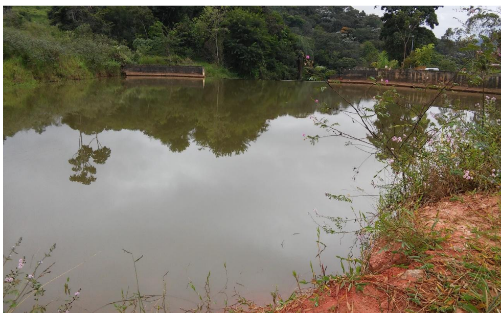
Figura 8 - Reservatório da barragem da ETA Pureza.
