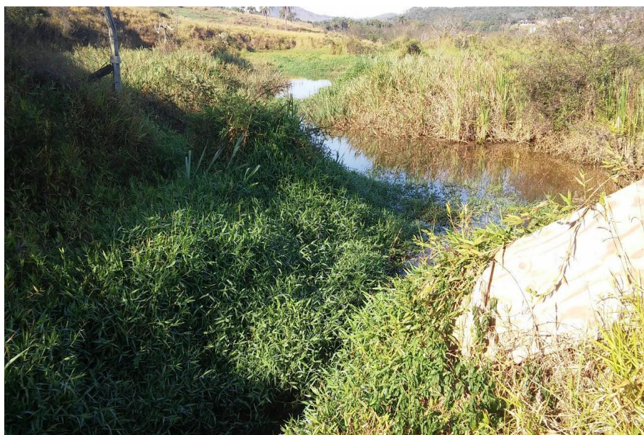
Figura 12 - Tomada de água provisória da ETA Pureza. Fonte: a autora.
