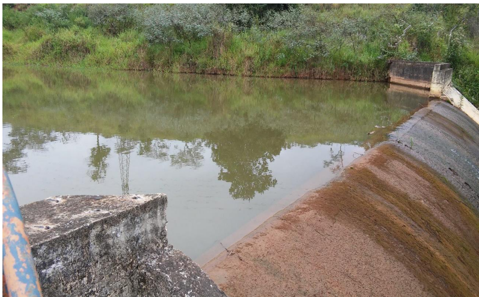
Figura 9 - Vertedouro da barragem da ETA Pureza.
