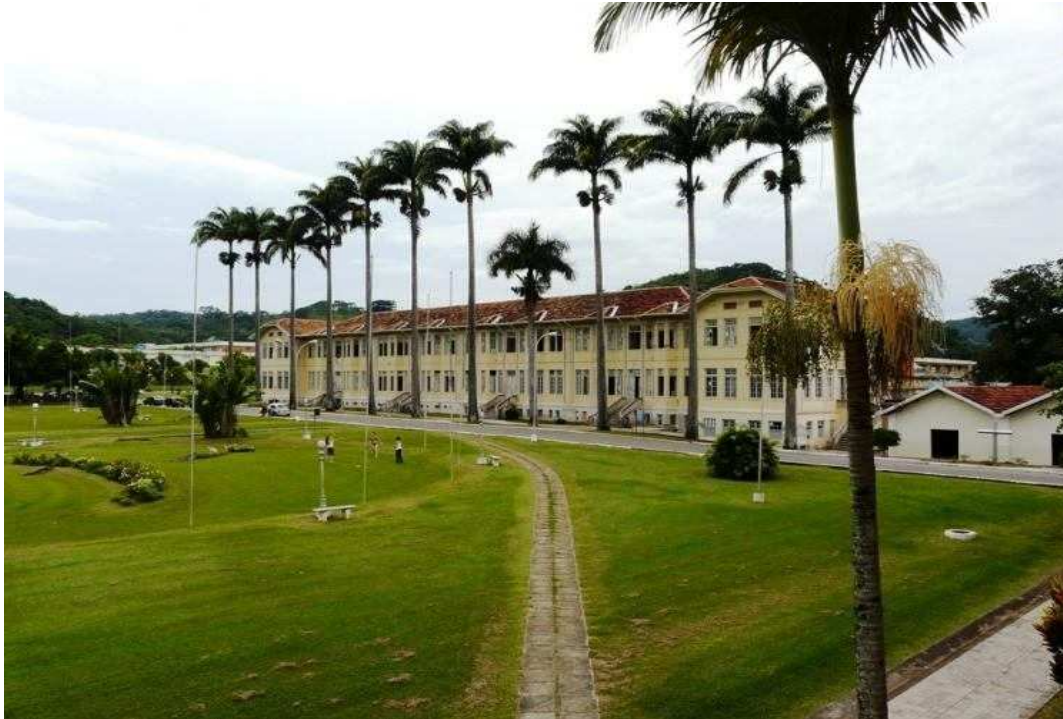
Figura 3. Vista parcial do alojamento feminino 23
