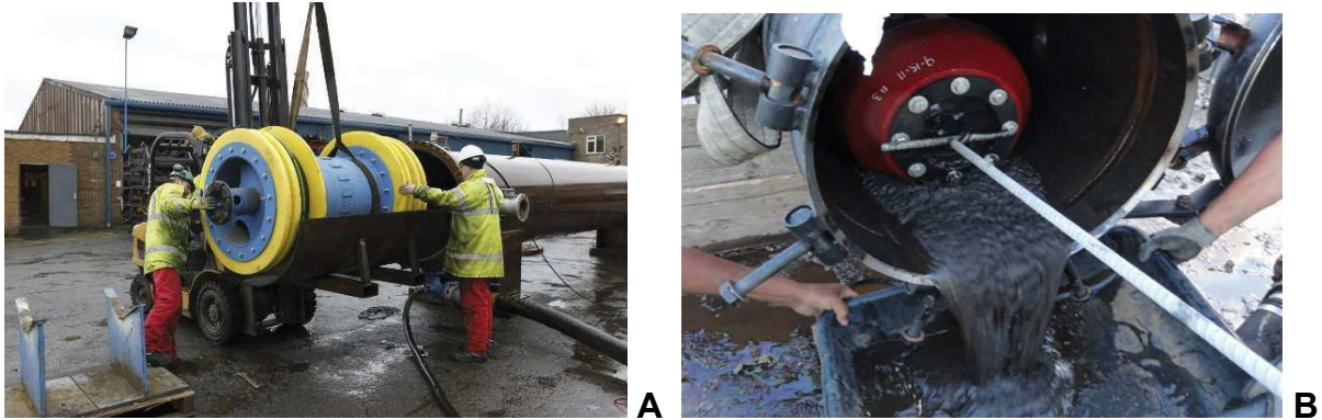
Figura 14. (A) Um PIG ( Pipeline Inspection Gauge ) sendo introduzido em um lançador de PIG para início da passagem por um duto (NORD STREAM, 2021). (B) Um PIG sendo retirado de um duto após sua passagem, trazendo consigo os resíduos removidos das paredes internas do duto (PIPING WORLD, 2019).
