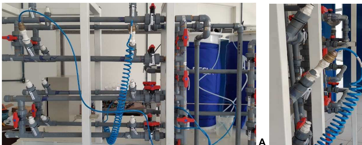
Figura 39. Sistema de purga de gás nitrogênio por engate rápido nos sistemas piloto laboratoriais de fluxo dinâmicos ( Loopings ) da UFV. (A) Engate em cada um dos trechos da tubulação que contêm os cupons. (B) Detalhe do engate rápido.
