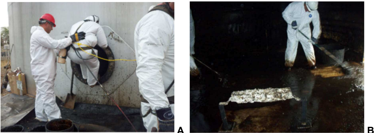
Figura 15. (A) Equipe entrando em um tanque de armazenamento de petróleo para realização da limpeza. (B) Limpeza interna de um tanque por jateamento (CHRYSALIDIS; KYZAS, 2020).
