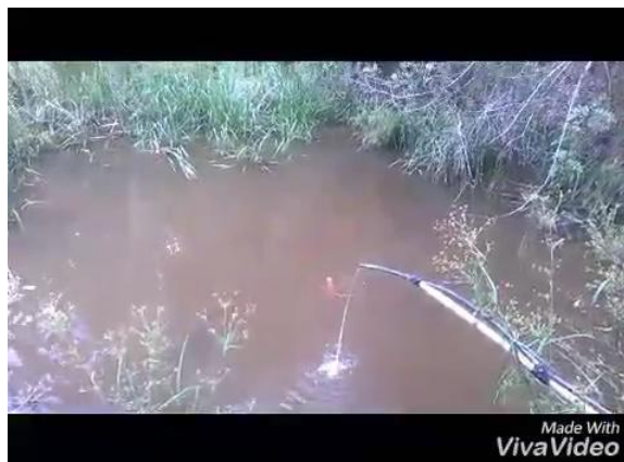
Figure 6 Frame from ‘Carneiro Hidráulico/Water Pump’.
