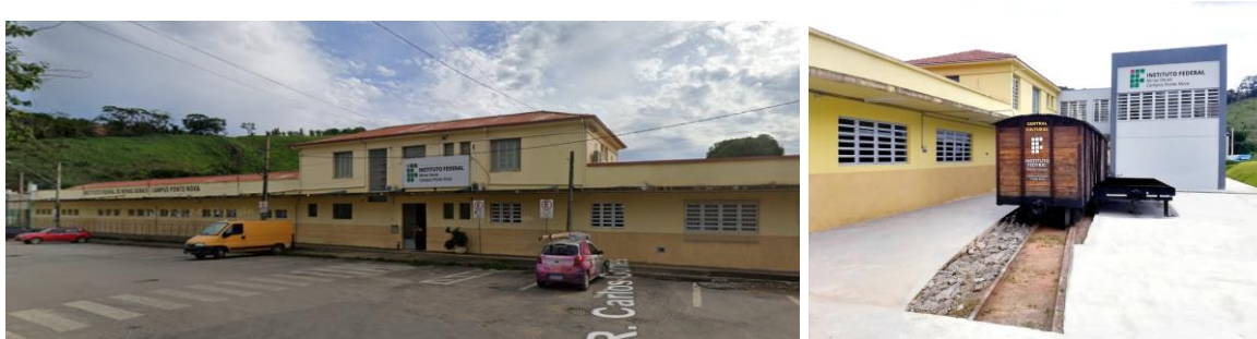
Figura 09 – Vistas da antiga estação da Central – atual IFMG – (2024 e 2019)
