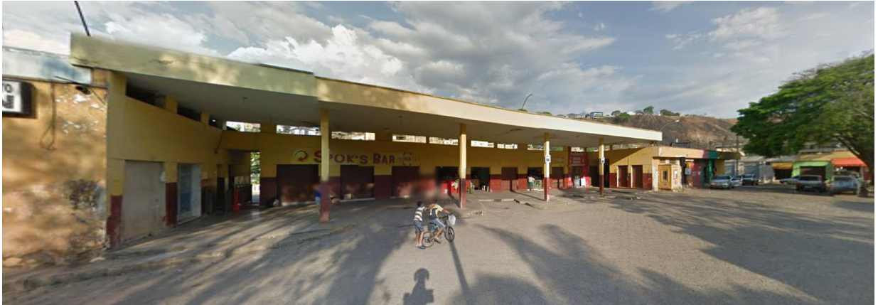
Figura 13 – “Rodoviária Velha” antes da reforma – Setembro de 2013
