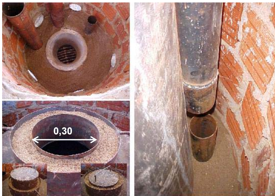
Figura 9 – Vedações e engate do tubo condutor de gás.
