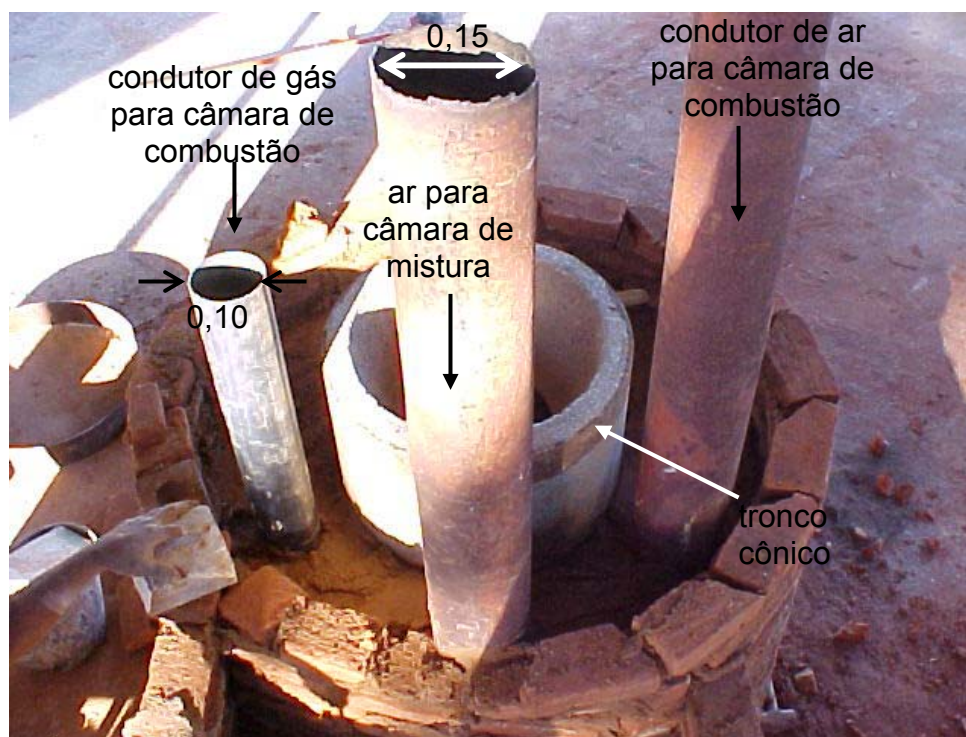
Figura 6 – Instalação de tubos condutores e do tronco cônico.
