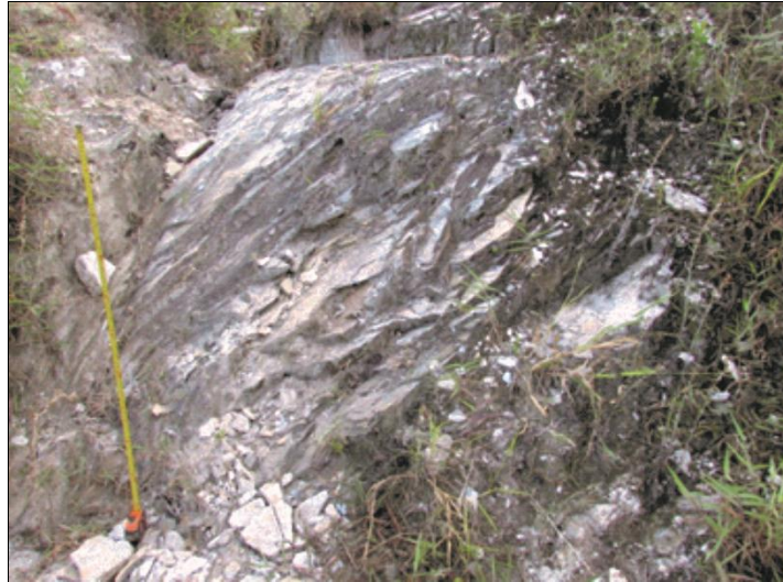
Figura 11 - Afloramento de filito W2 no perfil FIL01
