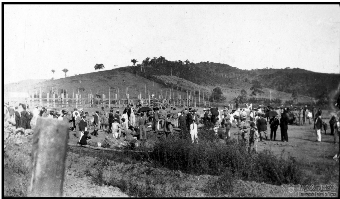
Figura 34a - Público presente na celebração de lançamento da pedra fundamental do Prédio Principal
