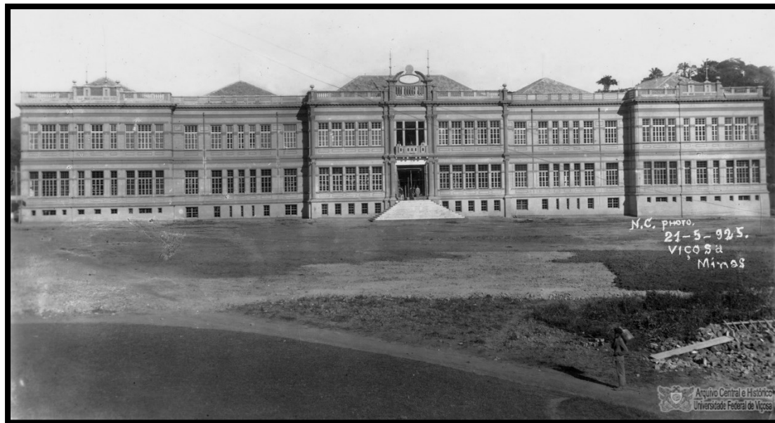
Figura 37 - Prédio principal, aparentemente terminado (fachada voltada para a cidade)
