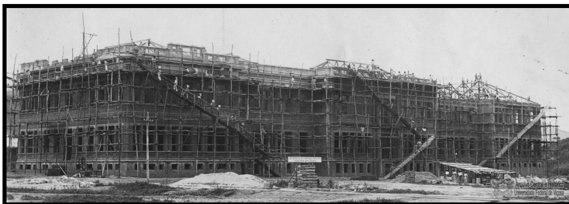
Figura 35a - Prédio principal em construção
