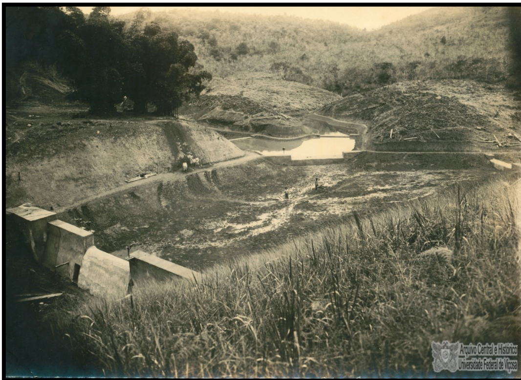
Figura 69 - Construção da represa de água potável
