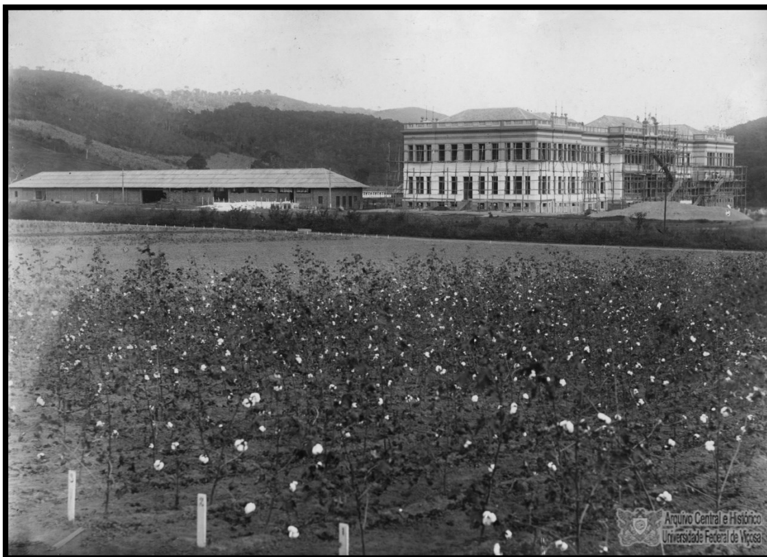
Figura 50 - Plantação de algodão em primeiro plano, ao fundo barracão de obras e prédio principal em construção
