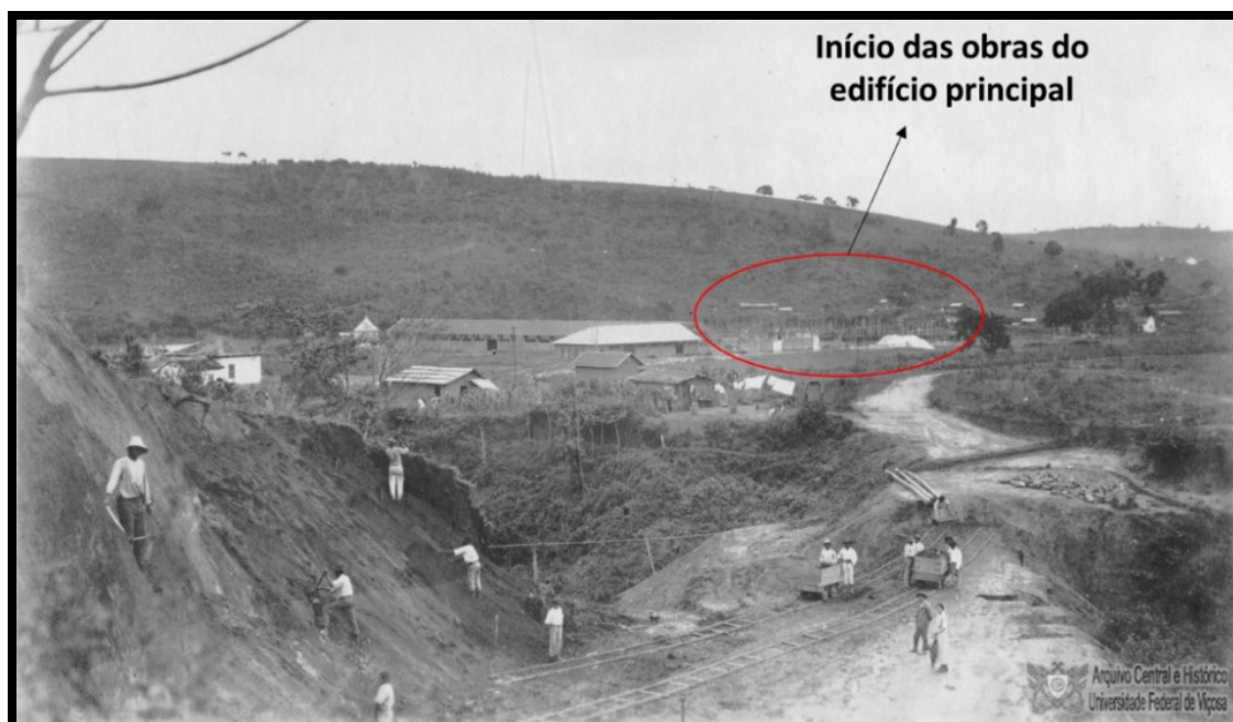
Figura 66 - Operários trabalhando na etapa final do aterro no córrego dos Barbados
