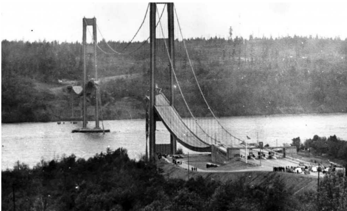
Figura 18 - Colapso na ponte de Takoma
