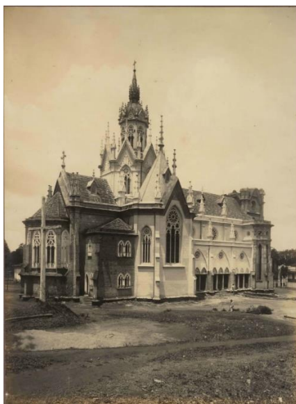
Figura 16- Construção da Igreja Matriz de Nossa Senhora da Boa Viagem, 1923.
