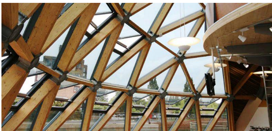
Figura 11 – Travamento para membros discretos em Pods Sports Complex.
