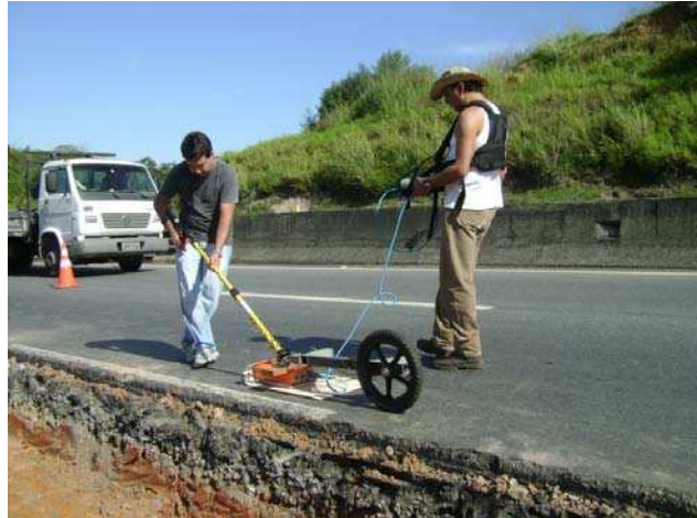
Figura 6.15 - Trecho do experimento - pista sul da via Dutra (RJ)
