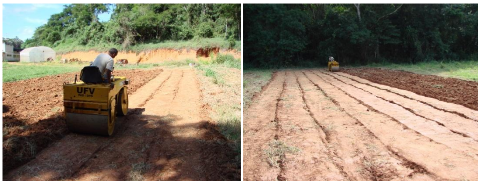
Figura 3 – Compactação das faixas utilizando rolo compactador, marca Dynapac, modelo CG 110, largura de 90 cm e peso de 750 kgf.
