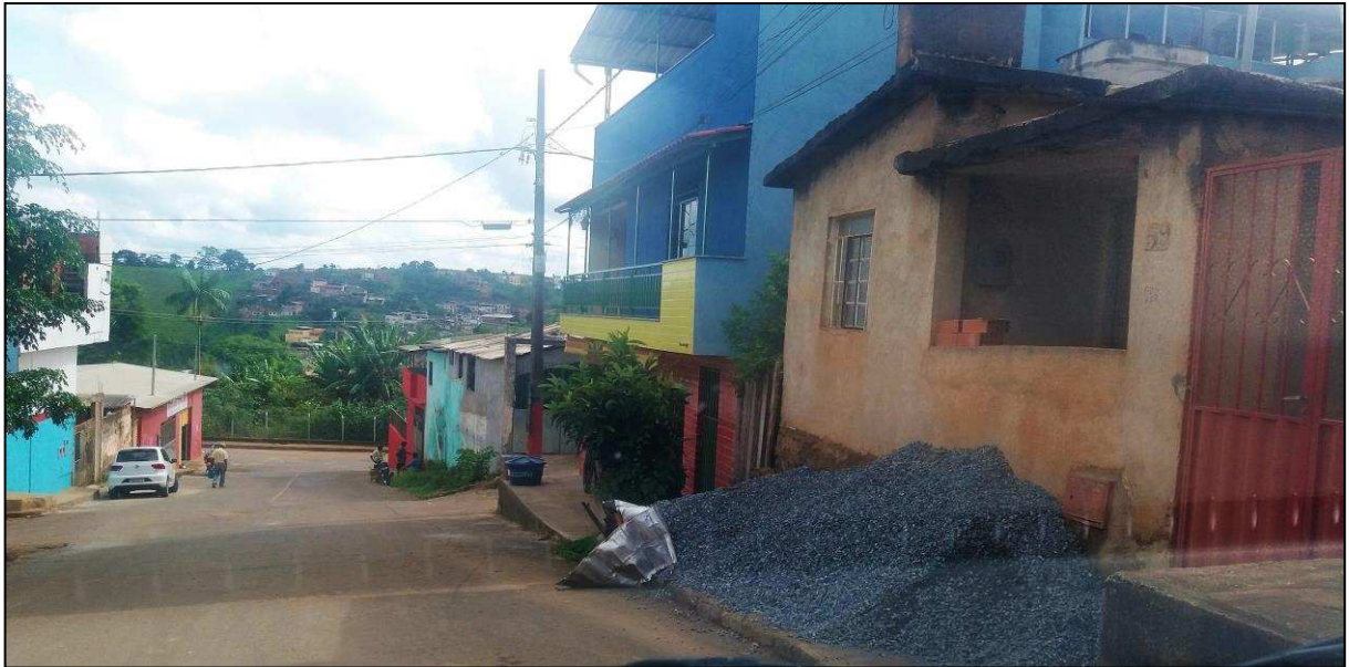
Figura 4: Presença de materiais de construção nas calçadas de praticamente todas as ruas do bairro Nova Viçosa. Fonte: Acervo da pesquisadora, 2017.
