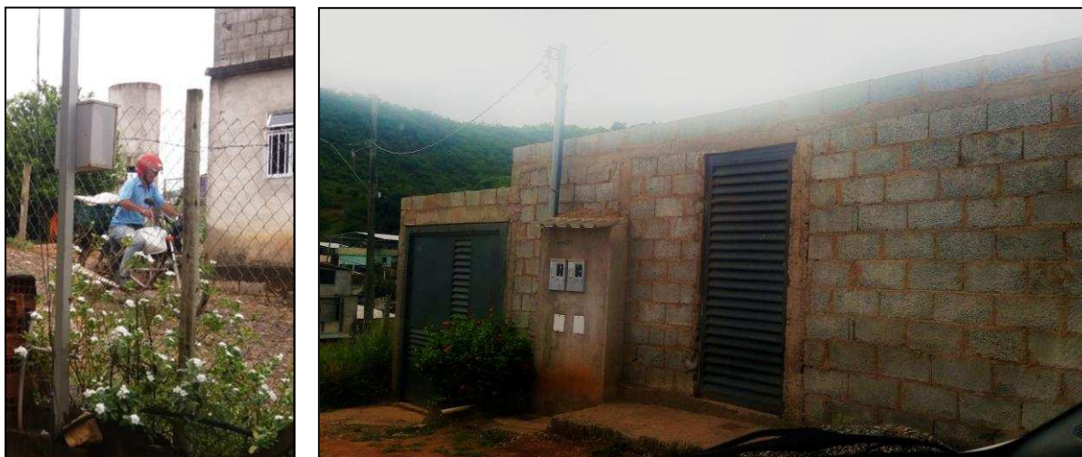
Figuras 19 e 20: À esquerda, foto do entregador de compras que não encontrava uma determinada casa devido à numeração fora de ordem e à falta de sinalização correta das ruas. À direita, uma das várias casas do bairro que não apresentam nenhum tipo de numeração.
