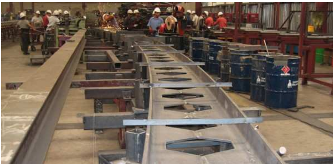
Figura 2 – Fabricação de uma viga castelada curva.
