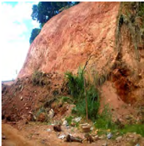
a) Talude anteriormente exposto.
