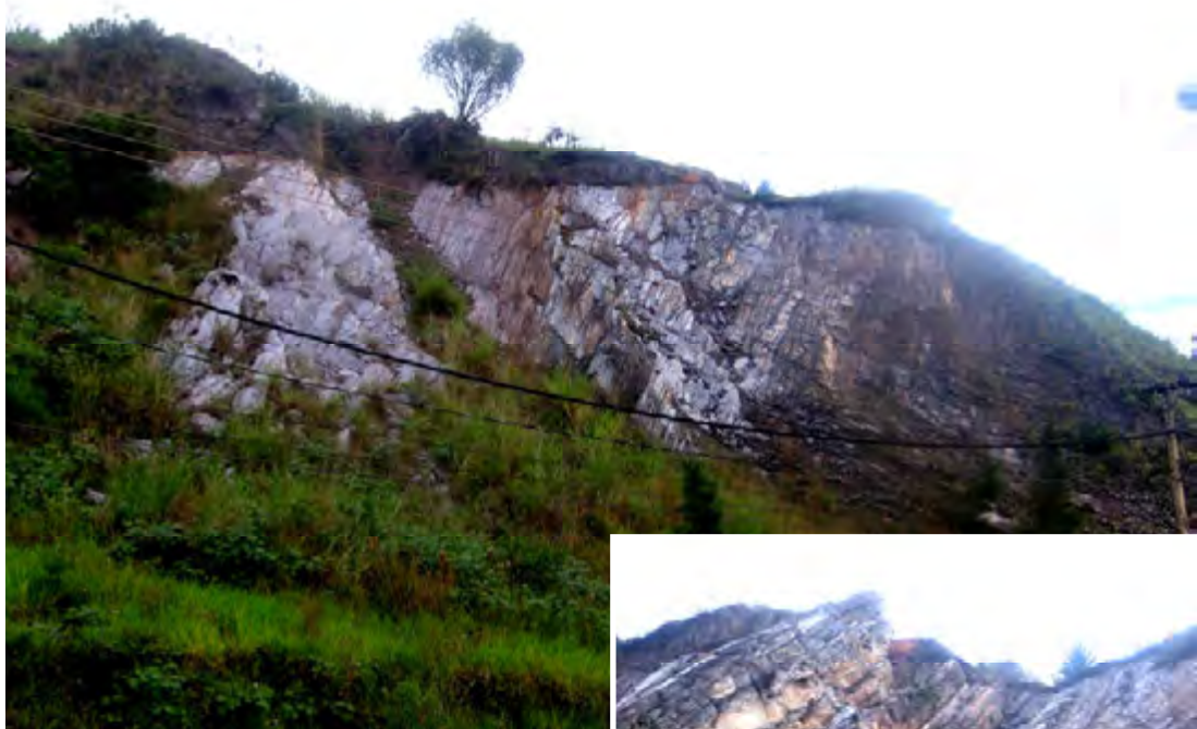
Figura 5.10 – Ocorrência de escorregamento de solo e queda de detritos na av. Raja Gabaglia.
