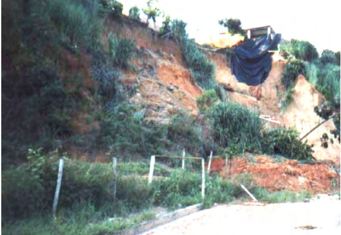
Figura 5.6 – Escorregamento rotacional, no bairro Engenho Nogueira (quadrícula H4 da Figura 5.3).
