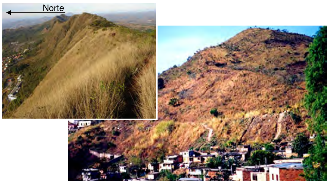
Figura 5.8 – Possibilidade “baixa” a “média” de escorregamento ou queda de rochas nas moradias ao pé de um dos contrafortes da Formação Cauê, na Serra do Curral, com superfície voltada para o quadrante NW.
