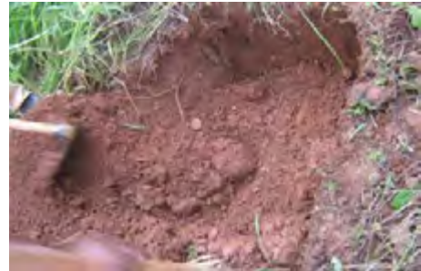
Abertura de vala.
