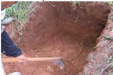
Preparação para cravação.
