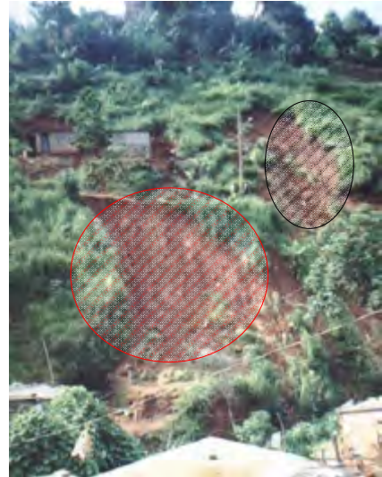
Situação após a ruptura (Janeiro de 2003).
