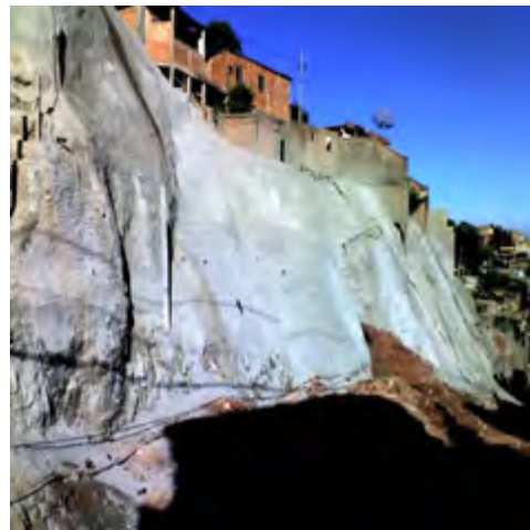
b) Proteção do talude.
