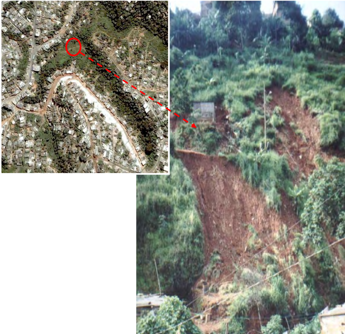
Figura 5.17 – Escorregamento ocorrido em janeiro de 2003, em localidade do estudo de caso – Foto 1.
