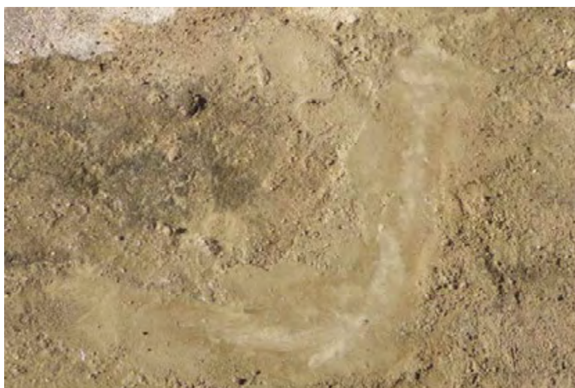
Figura 4. 24 – Área de inspeção recomposta com argamassa estrutural (Marquise SR 481).
