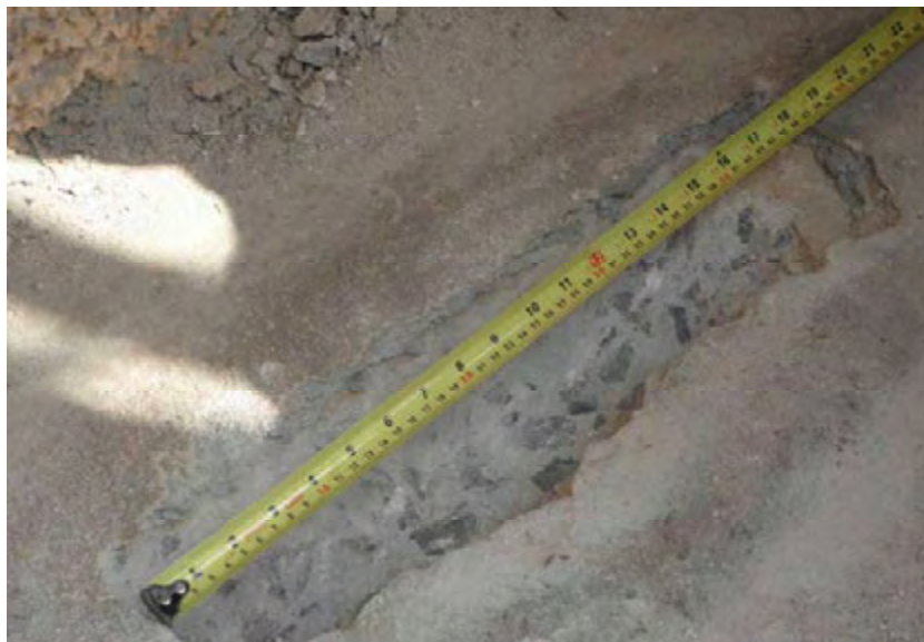
Figura 4. 18 – Intervenção em marquise sem possibilidade de identificação de armadura (Marquise JCR 158).
