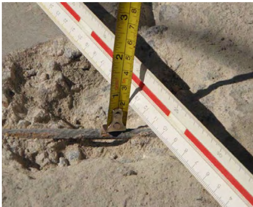
Figura 4. 15 – Determinação de cobertura de armadura (Marquise SR 481)
