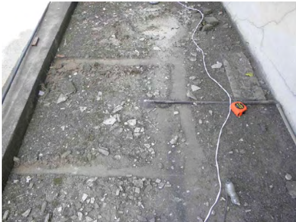
Figura 5: Vista parcial marquise PEJ 79 – Detalhe: contorno em alvenaria.
