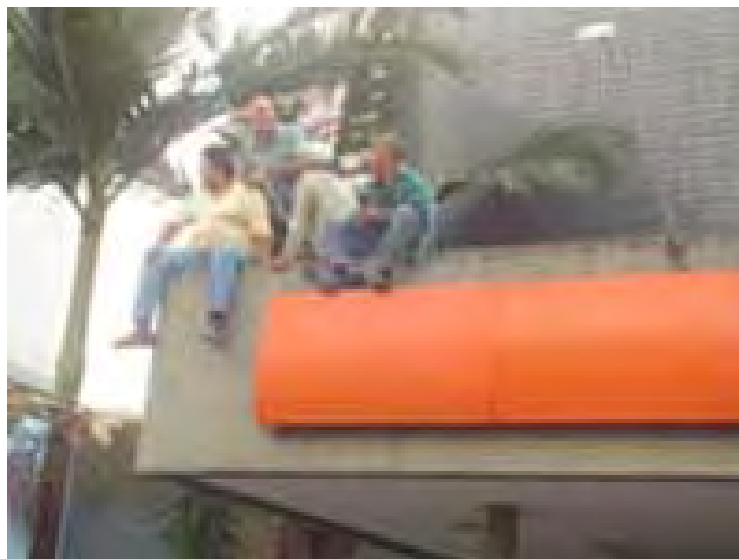
Figura 2. 8 - Utilização inadequada de marquises por pessoas. Fonte: http://www.acesa.com . Acesso: Outubro de 2010.
