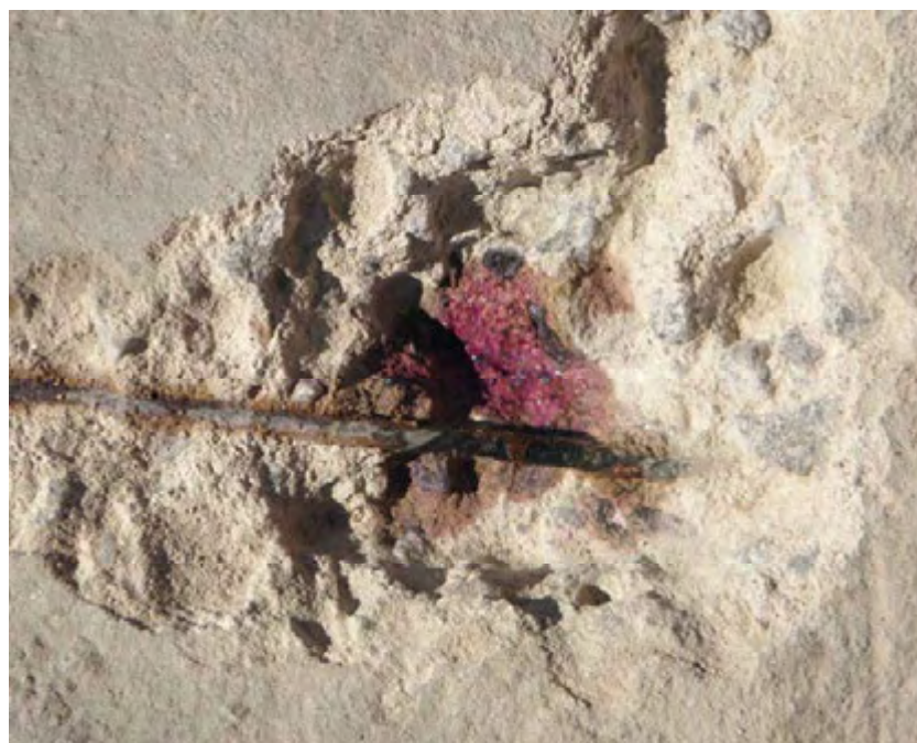
Figura 4. 21 – Verificação de profundidade de carbonatação (Marquise SR 481).
