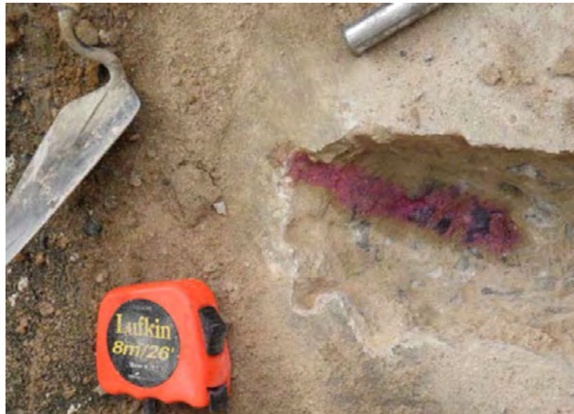
Figura 4. 20 – Verificação de profundidade de carbonatação (Marquise BA 88).
