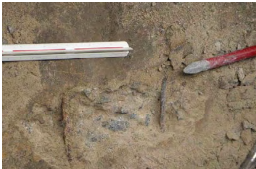
Figura 4. 16 – Detalhe de inspeção de armadura de marquise (Marquise MB 135)
