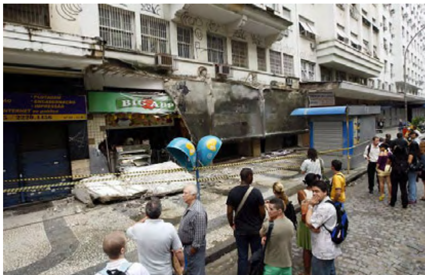
Figura 3. 12 - Desabamento de marquise Av. Avenida Churchil, Rio de Janeiro, RJ. Disponível em: http://oglobo.globo.com/rio . Acesso: Outubro 2010
