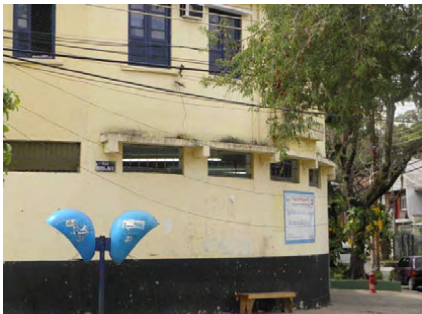
Figura 3. 21 - Marquise removida em quase sua totalidade
