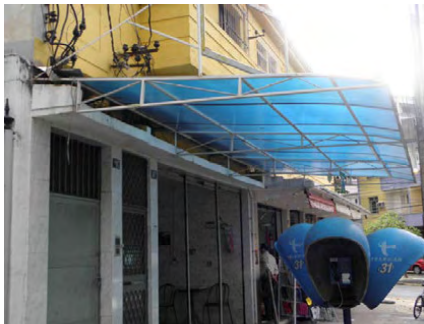
Figura 3. 20 – Marquise removida e substituída por cobertura de policarbonato.
