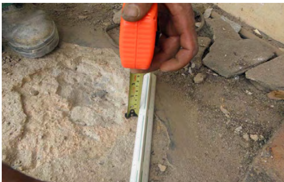
Figura 9: Medição de camada de revestimento superior
