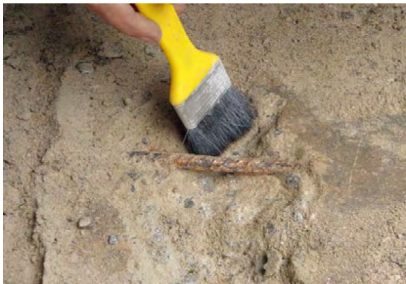
Figura 4. 23 – Limpeza para inspeção e recomposição (Marquise MB 135)
