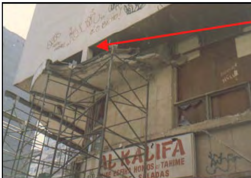
Figura 3. 1 - Marquise do edifício Mercúrio: escoramento emergencial para demolição. (JORDY e MENDES 2006)
