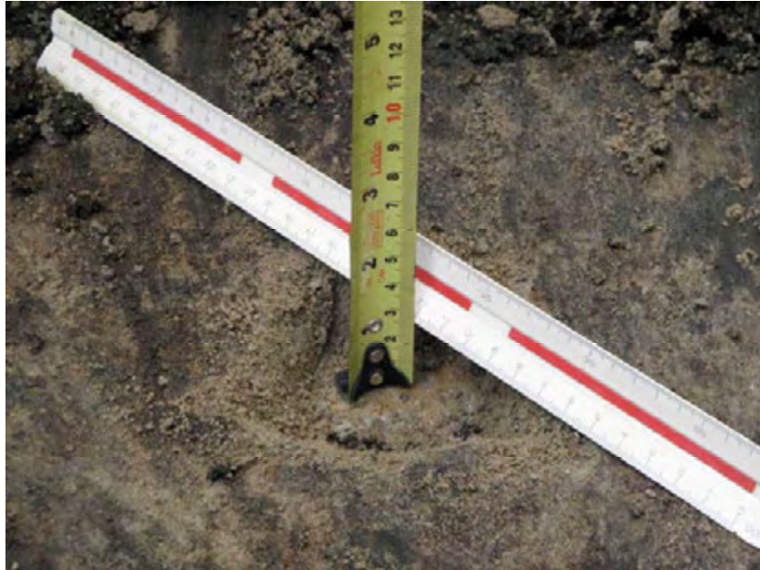
Figura 4. 5 - Medição de camada de revestimento superior – marquise MB 355.
