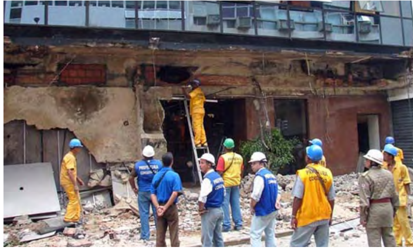
Figura 3. 2 - Desabamento de marquise do Hotel Canadá (2007). Fonte: http://oglobo.globo.com/rio - Acesso Setembro 2010.
