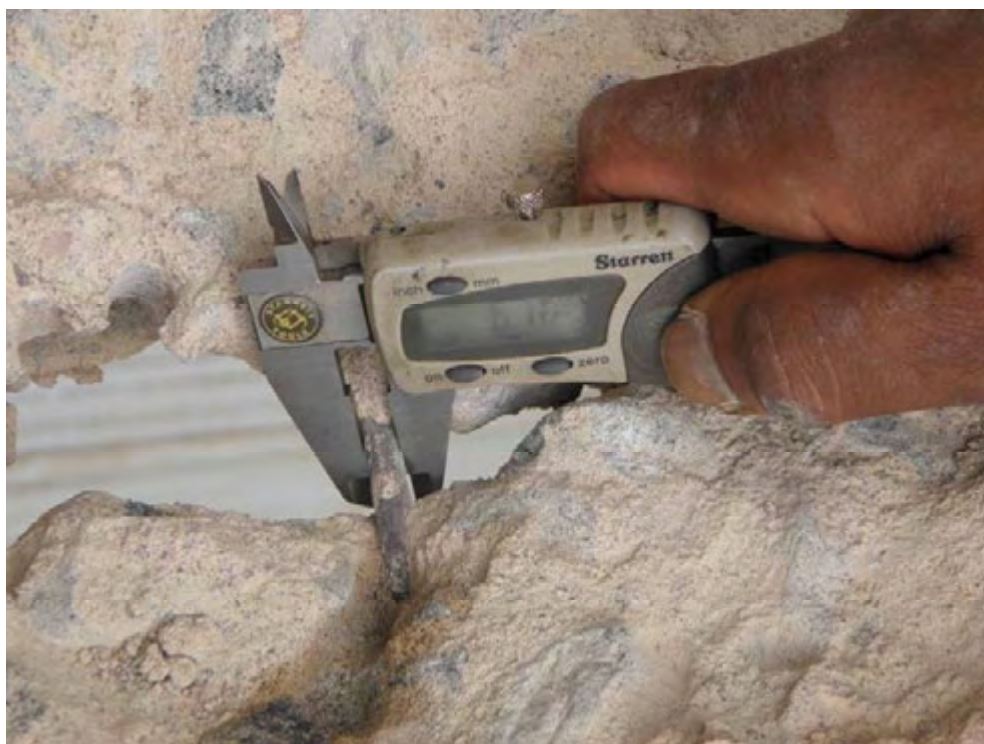
Figura 12: Medição de diâmetro de armadura.
