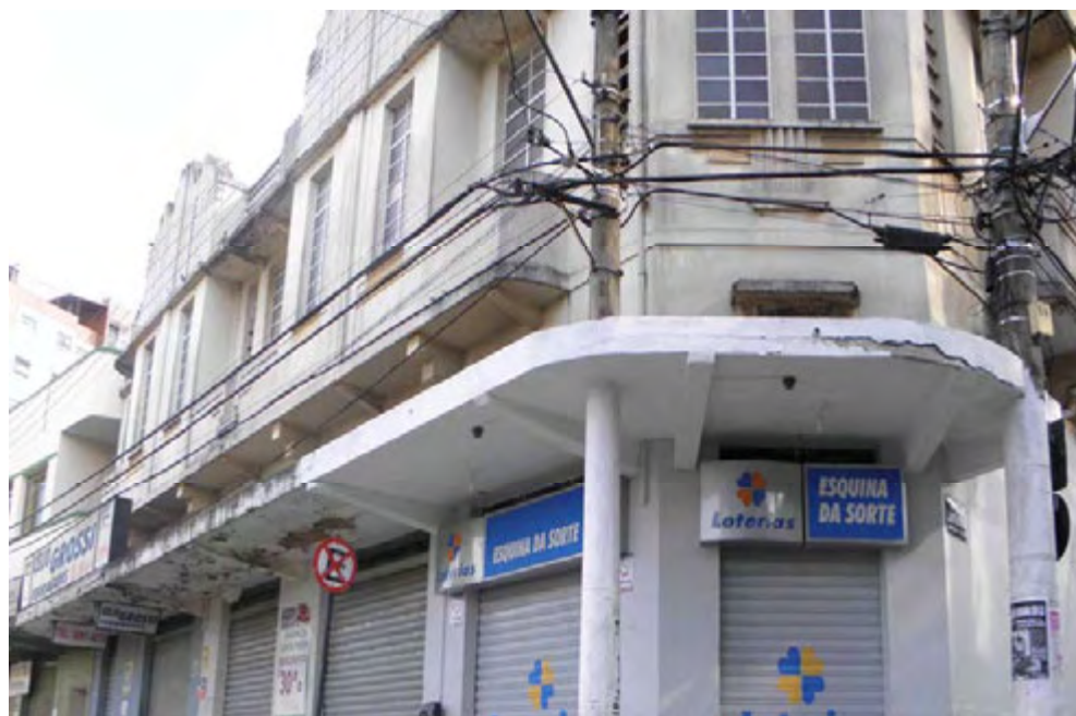
Figura 1: Vista geral da marquise PEJ 79, 2010.
