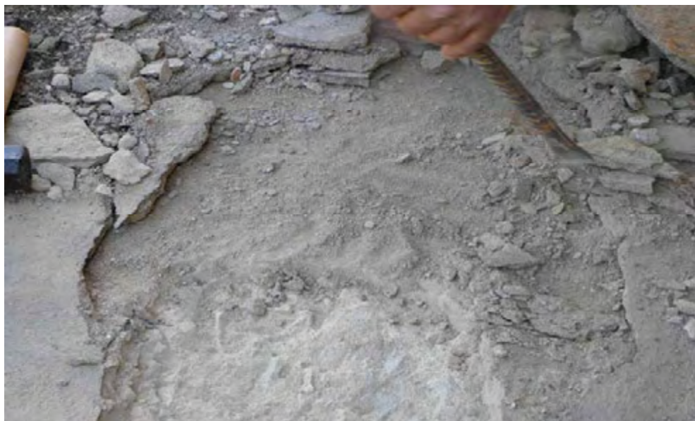
Figura 8: Remoção de camada de revestimento superior para inspeção no concreto
