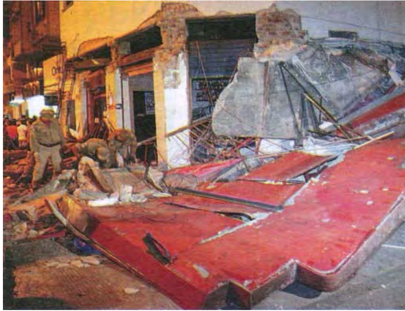
Figura 3. 10 - Queda de marquise: Bar Parada Obrigatória. Fonte: http :// fernanda mourao.wordpress.com . Acesso Outubro 2010.
