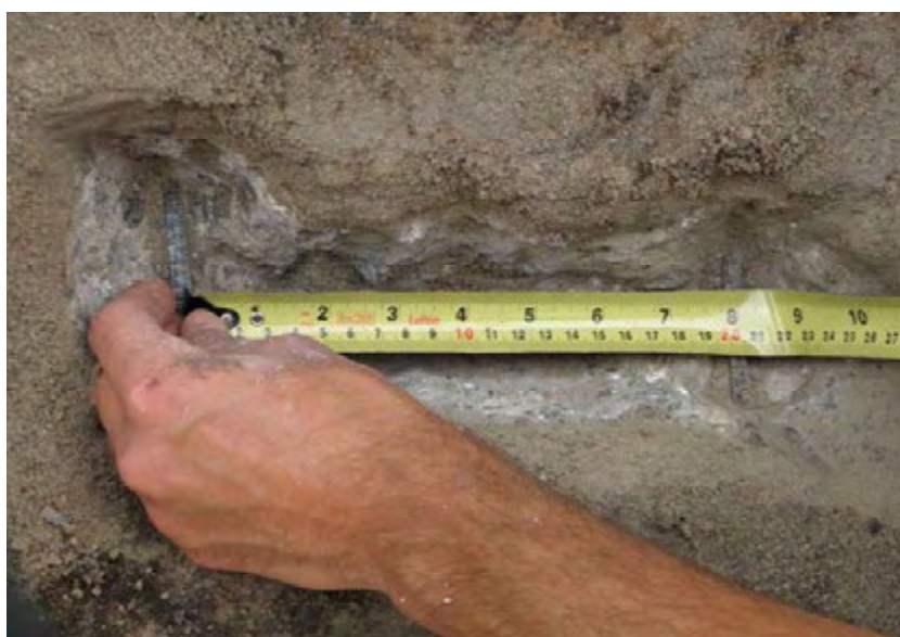
Figura 4. 14 – Estimativa de espaçamento entre barras de armadura negativa (Marquise MB 355).
