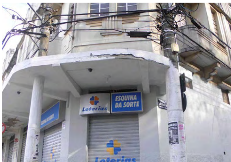
Figura 2: Trecho de marquise PEJ 79 em curva com poste de distribuição contidos em sua estrutura, 2010.
