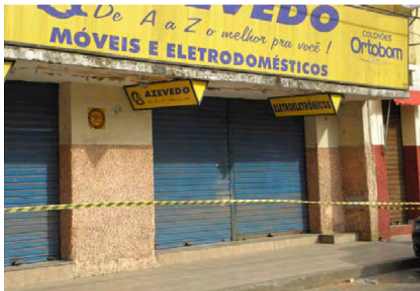
Figura 4. 10 – Isolamento de área sob marquise para inspeção.
