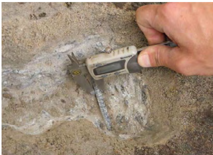
Figura 4. 13 – Determinação de diâmetro de armadura com uso de paquímetro digital (Marquise MB 355).
