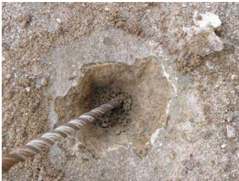
Figura 4. 11 – Abertura de janela de inspeção com auxílio de furadeira de impacto (Marquise SP 56).
