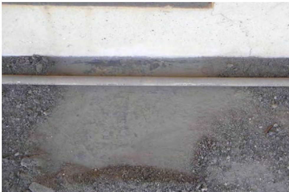
Figura 10: Marquise PEJ 79 – detalhe trecho de impermeabilização encontrado.
