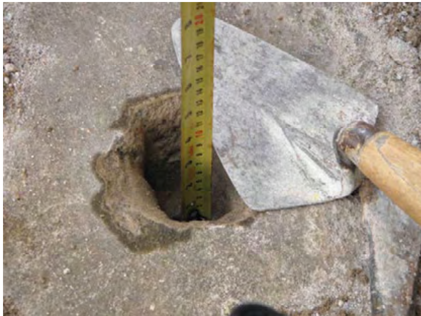
Figura 4. 6 - Medição de camada de revestimento superior – marquise SP 56.
