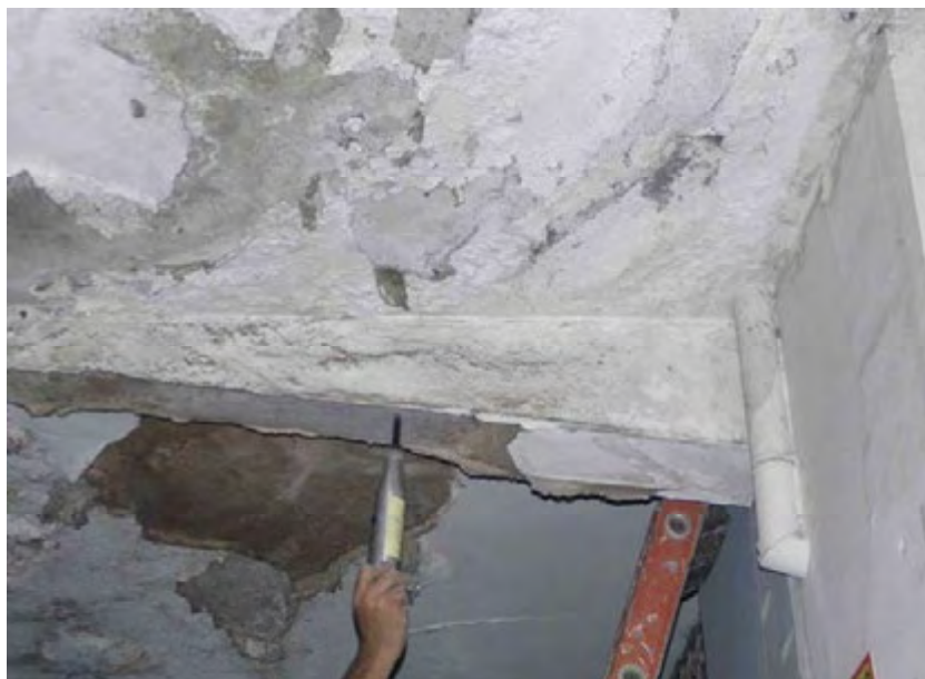
Figura 4. 22 – Ensaio esclerométrico em viga de apoio (Marquise PEJ 79).
