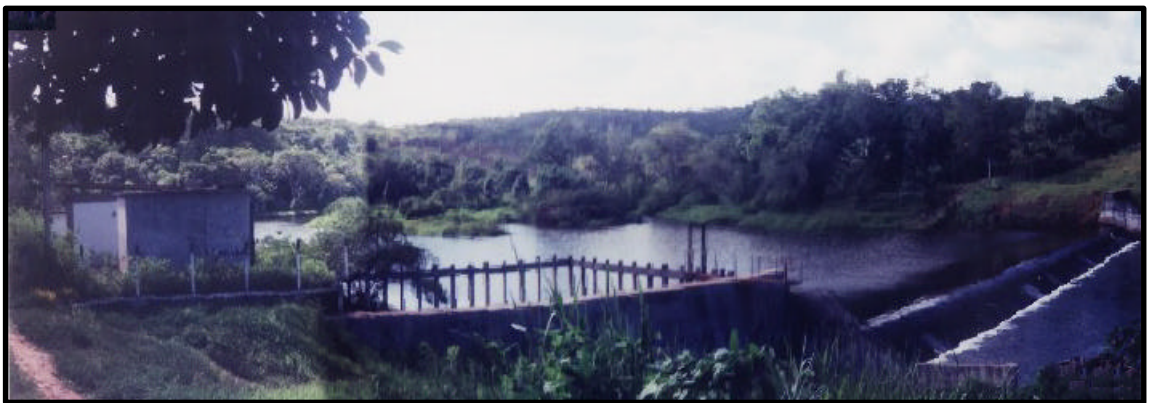
Figura 3 - Barragem situada no povoado Rio de Engenho.
