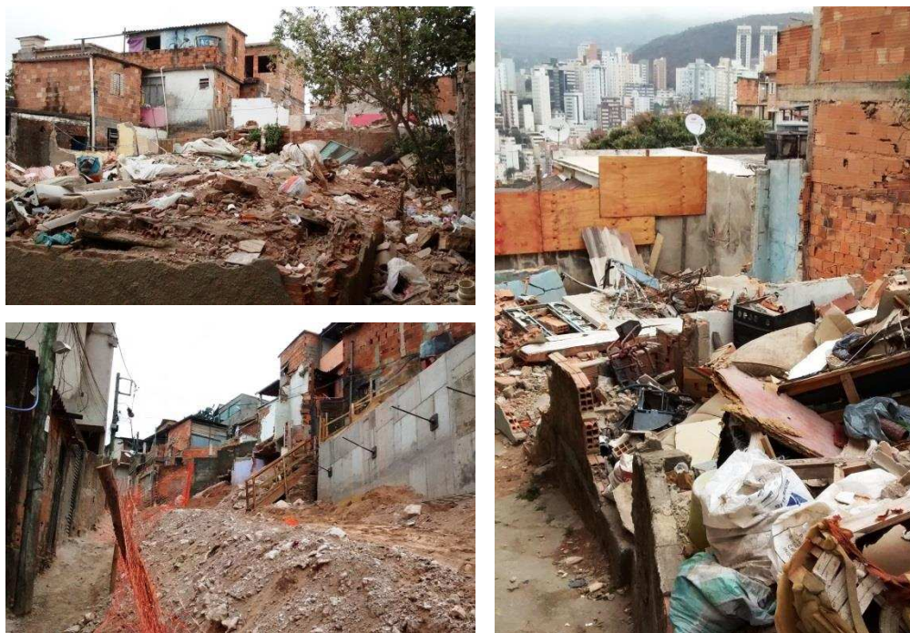
Figura 20 – Casas são demolidas na Vila e entulhos se acumulam
