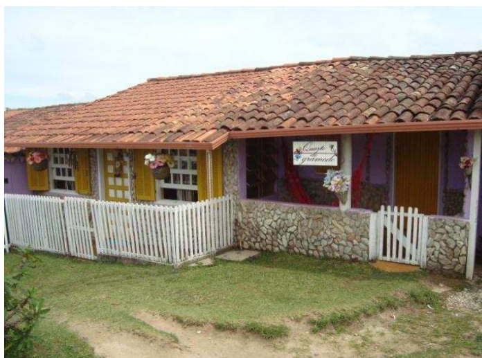
Figura 16 - Casas reformadas utilizando materiais contemporâneos
