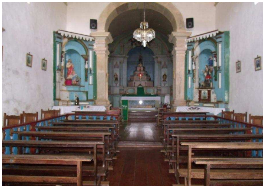
Figura 35- Foto interna da Capela de Nossa Senhora dos Prazeres Fonte: Arquivo pessoal - Data: Dez/2016
