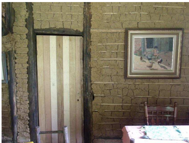
Figura 3 – Parede em pau a pique em restaurante de Lavras Novas
