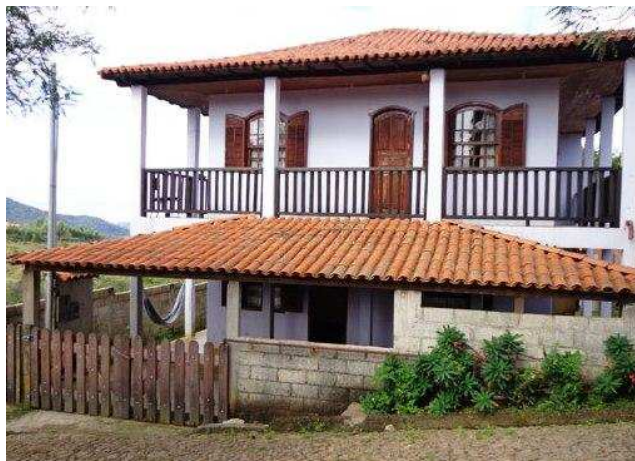
Figura 7- Casa com segundo andar construído
