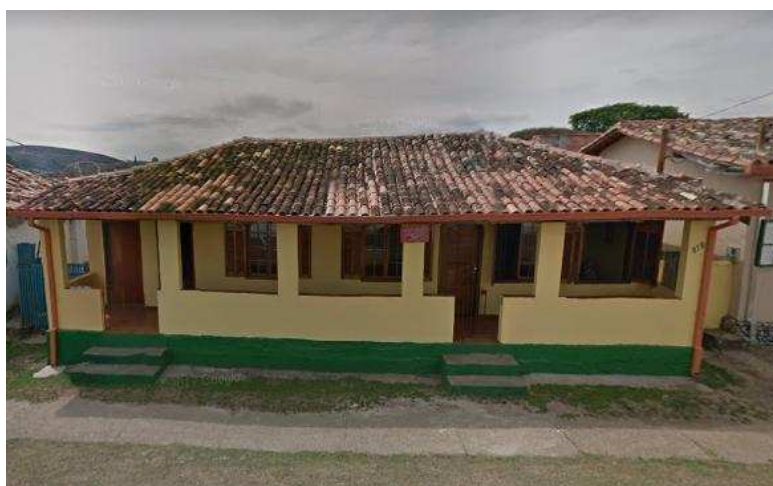
Figura 6 - Casa de origem colonial com varanda construída
