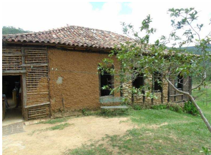
Figura 11 - Casa colonial adaptada como restaurante
