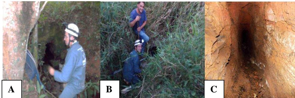
Figura 5. A - Abrigos naturais; B – Bueiros; C – Túnel de mineração abandonado. Fonte: Arquivo de Dr. Luciano C. H. P. Puga.
