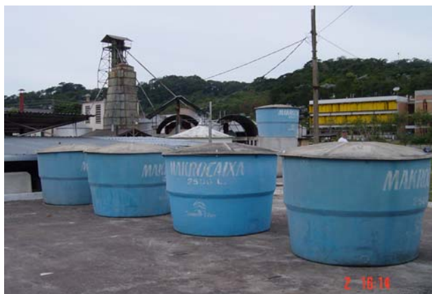
Figura 3. Vista dos secadores mecânicos
