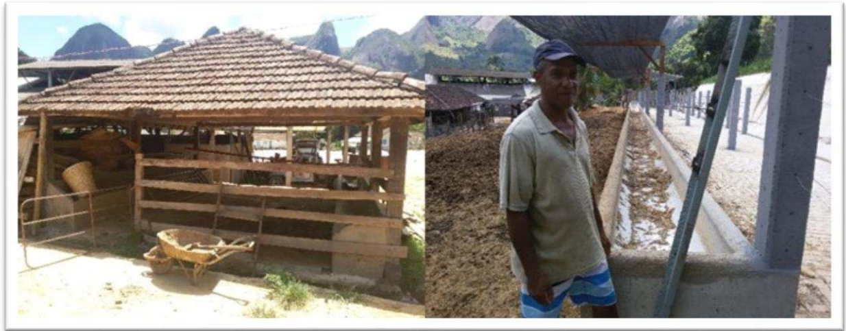
Figura 5 – Antiga instalação para o trato de matrizes em lactação (esquerda) e a nova instalação para arração das matrizes com capacidade para 50 animais divididos em 5 lotes (direita)
