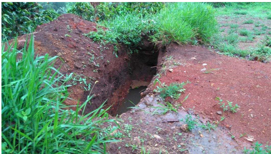
FIGURA 26: Construção de barraginha. Fonte: Alessandra Lomelino, 2017.
