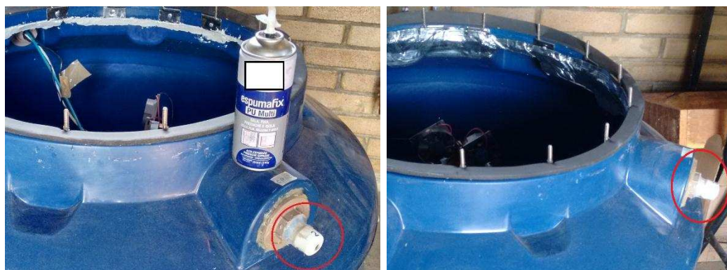
Figura 2.5 – Montagem da câmara. Destaque da conexão cap instalada.
