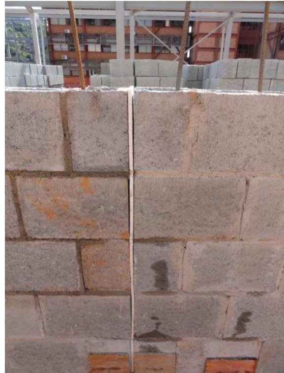
Figura 51 – Preenchimento do espaço de uma junta de movimentação com placas de EPS em uma alvenaria de blocos de concreto.
