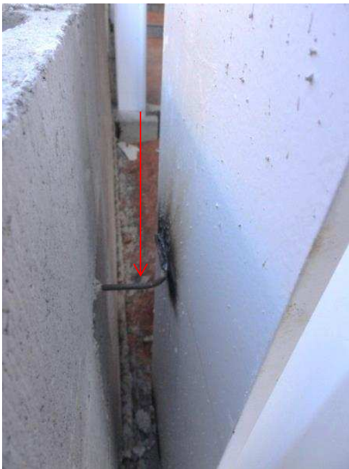
Figura 74 – Barra de fixação (ferro-cabelo).
