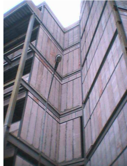
Figura 106 – Vista dos painéis de concreto celular autoclavados dispostos verticalmente, no Edifício do CCB-II (2002).
