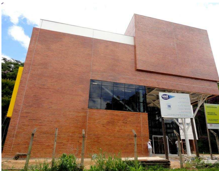
Figura 88 – Fachada do Edifício da CEAD.
