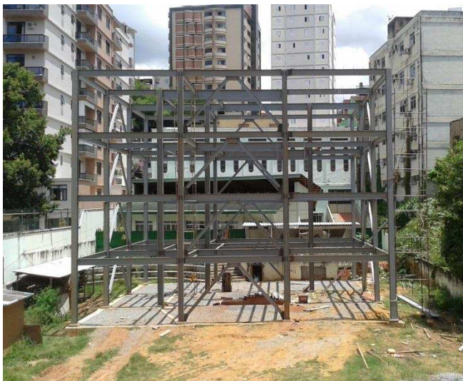
Figura 133 – Estrutura de aço do Edifício da IPV.
