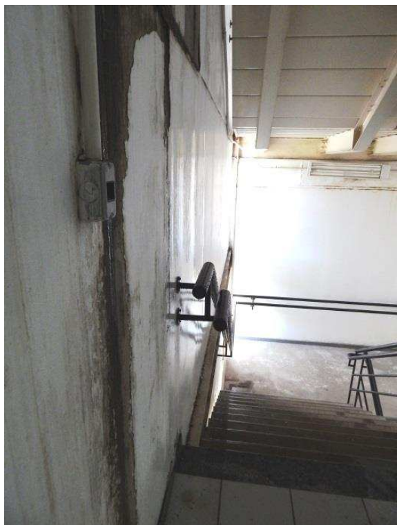
Figura 152 – Superfície interna da fachada durante a realização ensaio.
