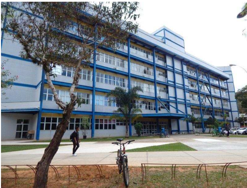
Figura 102 – Vista geral do Edifício do Centro de Ciências Biológicas II.
