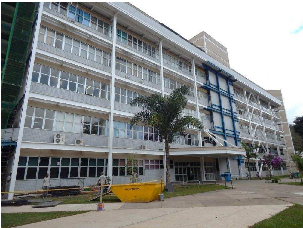
Figura 128 – Vista frontal do Edifício do CCB-II após a recuperação.
