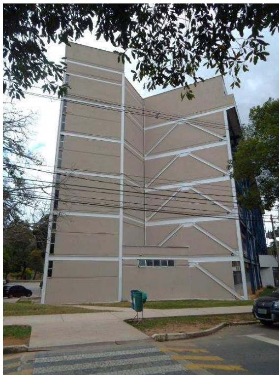
Figura 130 – Fachada posterior da caixa de escada após a recuperação.
