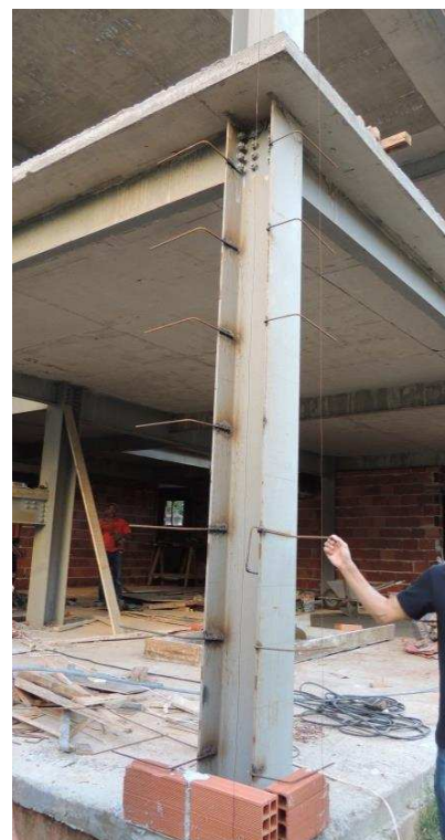
Figura 141 – Execução do detalhe de um pilar de canto com a alvenaria externa.
