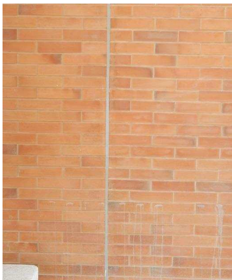
Figura 11- Junta de movimentação na fachada, com acabamento em selante.
