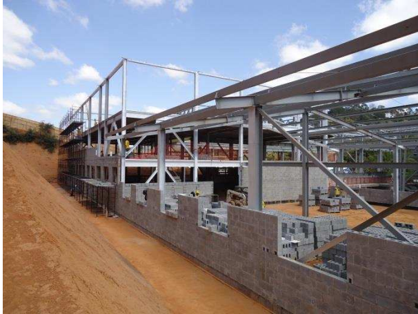
Figura 72 – Execução da alvenaria de blocos de concreto externa à estrutura metálica.
