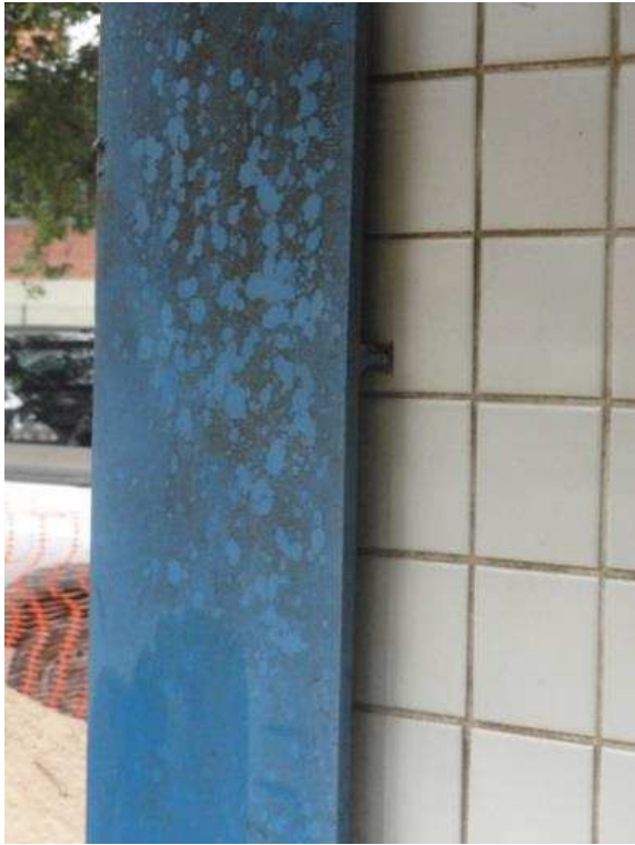
Figura 124 - Encontro alvenaria – alma do perfil de aço, antes (a) e depois (b) da intervenção.
