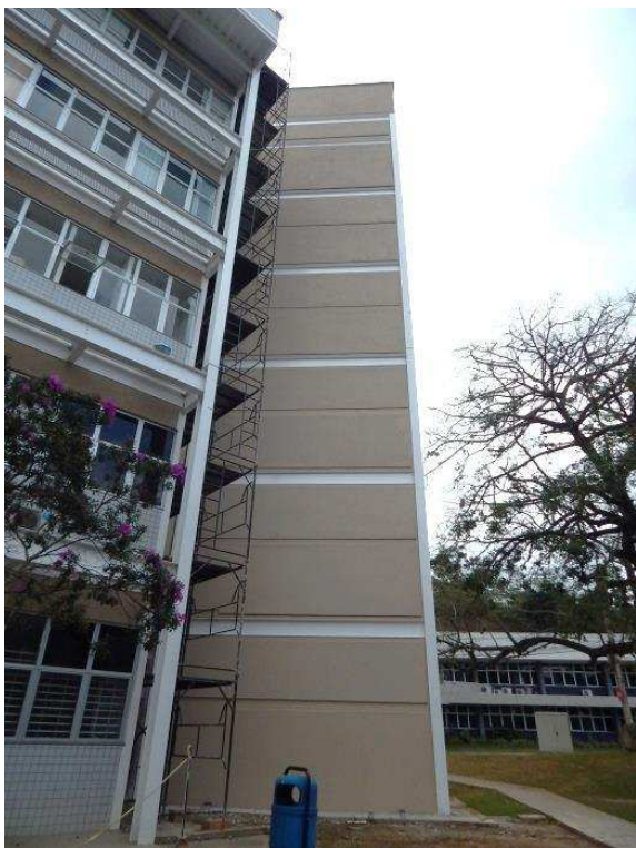
Figura 129 – Fachada lateral da caixa de escada após a recuperação.
