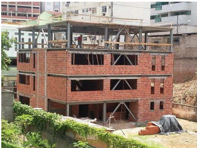
Figura 138- Vista geral da execução da alvenaria externa do edifício da obra social da IPV.
