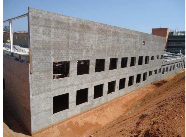
Figura 73 – Aspecto geral da alvenaria, que reveste a estrutura metálica.
