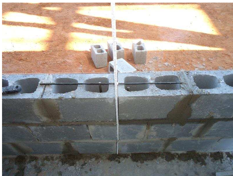
Figura 80 – Execução da junta de movimentação no Edifício LBE.
