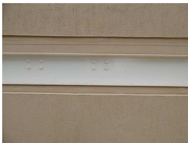
Figura 123 – Interface viga metálica – alvenaria, antes (a) e depois (b) da intervenção.
