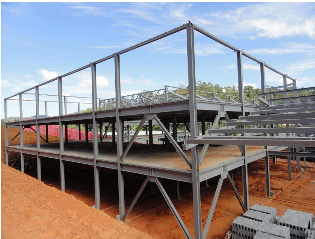
Figura 68 – Aspecto geral da estrutura de aço do Edifício LBE
