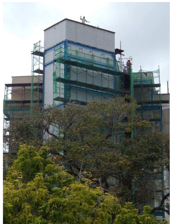
Figura 143 - Fachada da caixa de escada onde foi realizado o ensaio.
