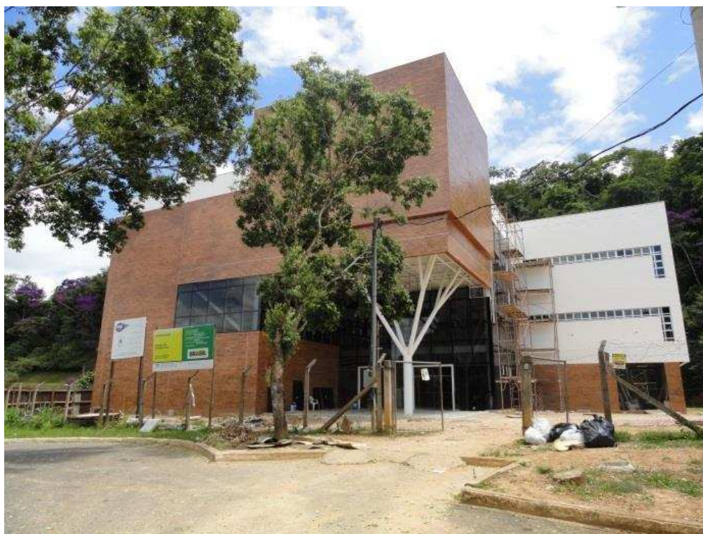
Figura 81 – Vista geral do Edifício da CEAD em fase de execução.
