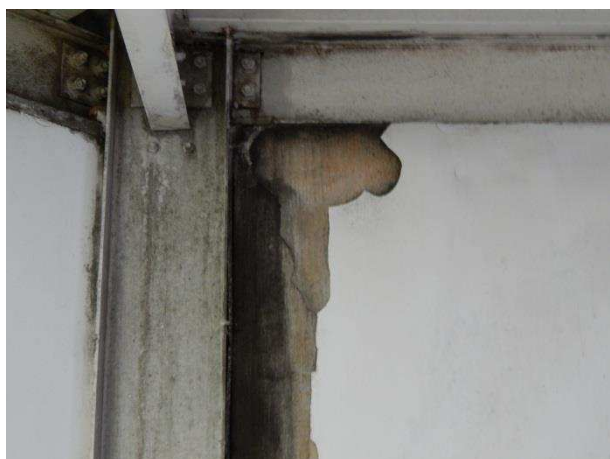
Figura 160 – Ausência da passagem de água em local crítico durante todo o experimento.
