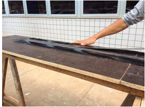
Figura 48 – Aplicação da fita de caldeação sobre a manta EPDM antes de ser posicionada no local.
