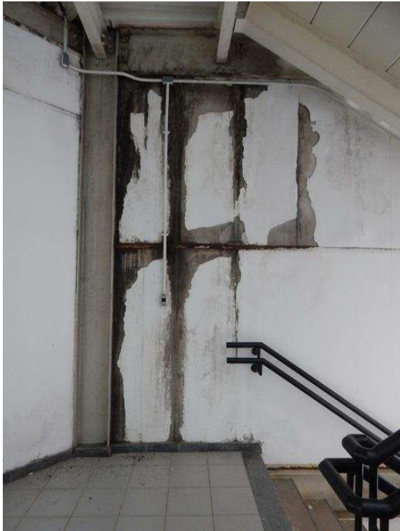
Figura 149 – Ambiente interno da caixa de escada antes da realização do ensaio.
