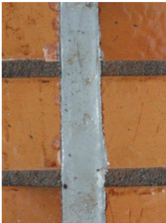
Figura 89 – Junta de movimentação na fachada com acabamento em selante acrílico.
