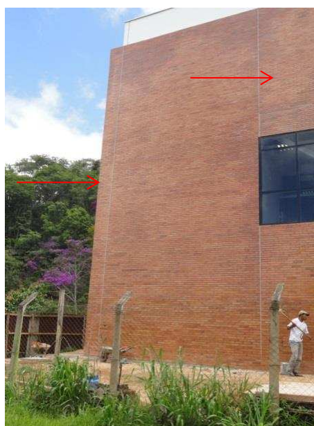
Figura 58 - Fachada do Edifício da CEAD - UFV, com as juntas de movimentação marcadas.
