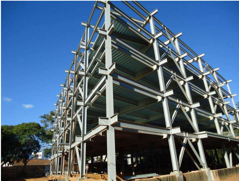
Figura 92 – Estrutura de aço do Edifício das Licenciaturas.
