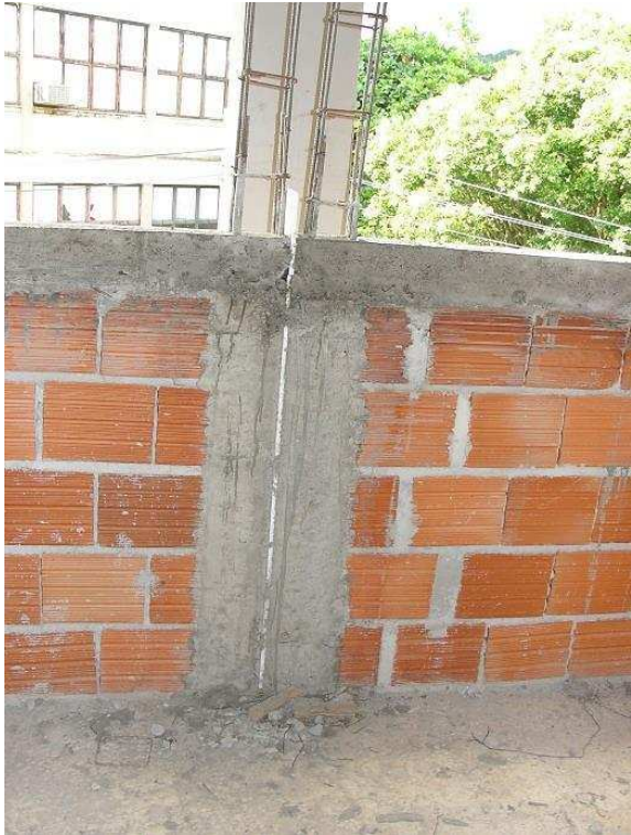
Figura 97 – Execução da junta de movimentação da alvenaria do Edifício das Licenciaturas.
