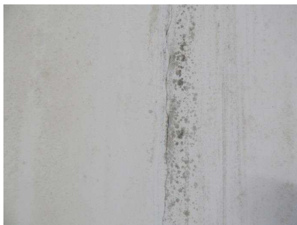
Figura 161 – Fissura permanece seca (durante o primeiro experimento era possível observar água corrente neste local).
