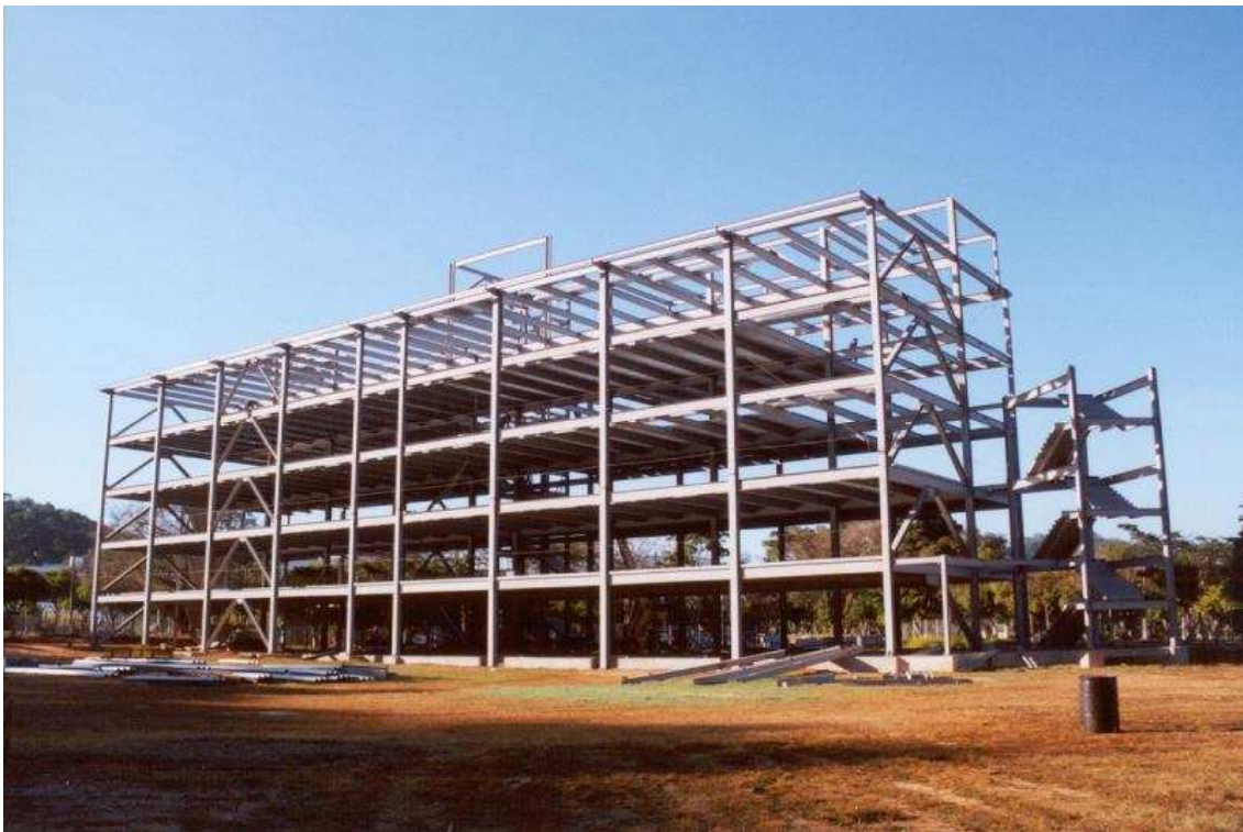
Figura 104 – Estrutura do Edifício do Centro de Ciências Biológicas e da Saúde.
