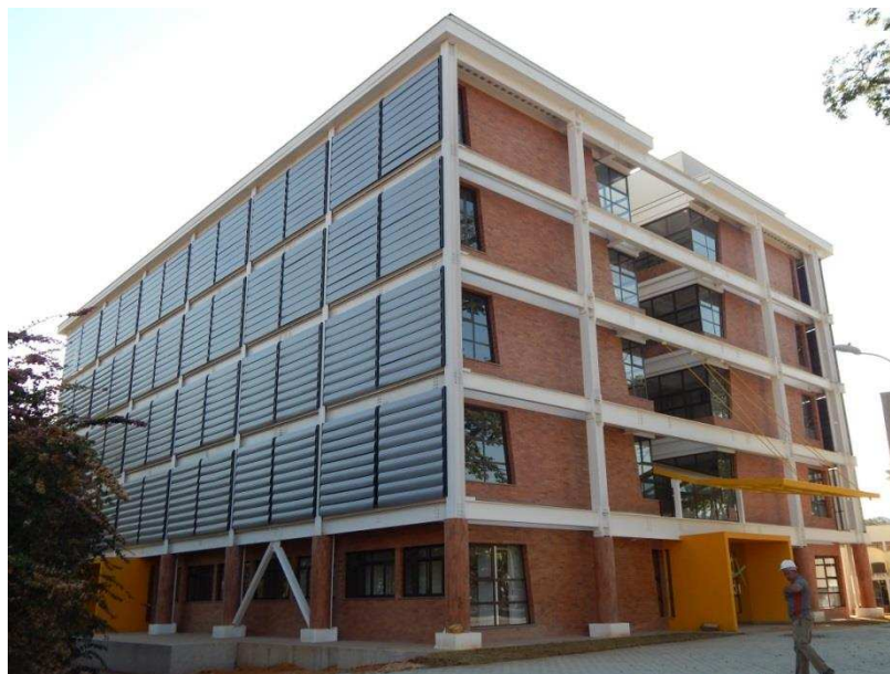
Figura 90 - Vista geral do Edifício das Licenciaturas.
