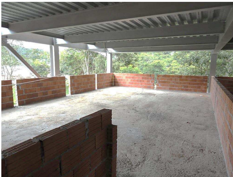
Figura 95 – Vista interna da alvenaria do Edifício das Licenciaturas.
