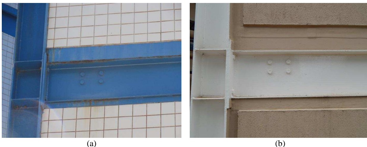
Figura 121 – Interface viga de aço – arremate lateral do steel deck e alvenaria, antes (a) e depois (b) da intervenção.
