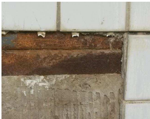
Figura 122 – Local da junção dos painéis de CCA, antes (a) e depois (b) da intervenção.
