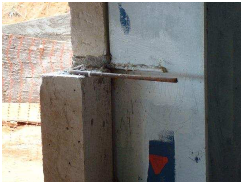
Figura 87 - Vista da execução do conector utilizado na interface entre alvenaria externa e coluna de aço.
