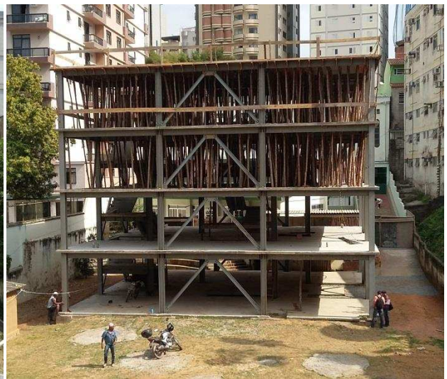
Figura 134 – Execução das terceira e quarta lajes maciças do Edifício da IPV.
