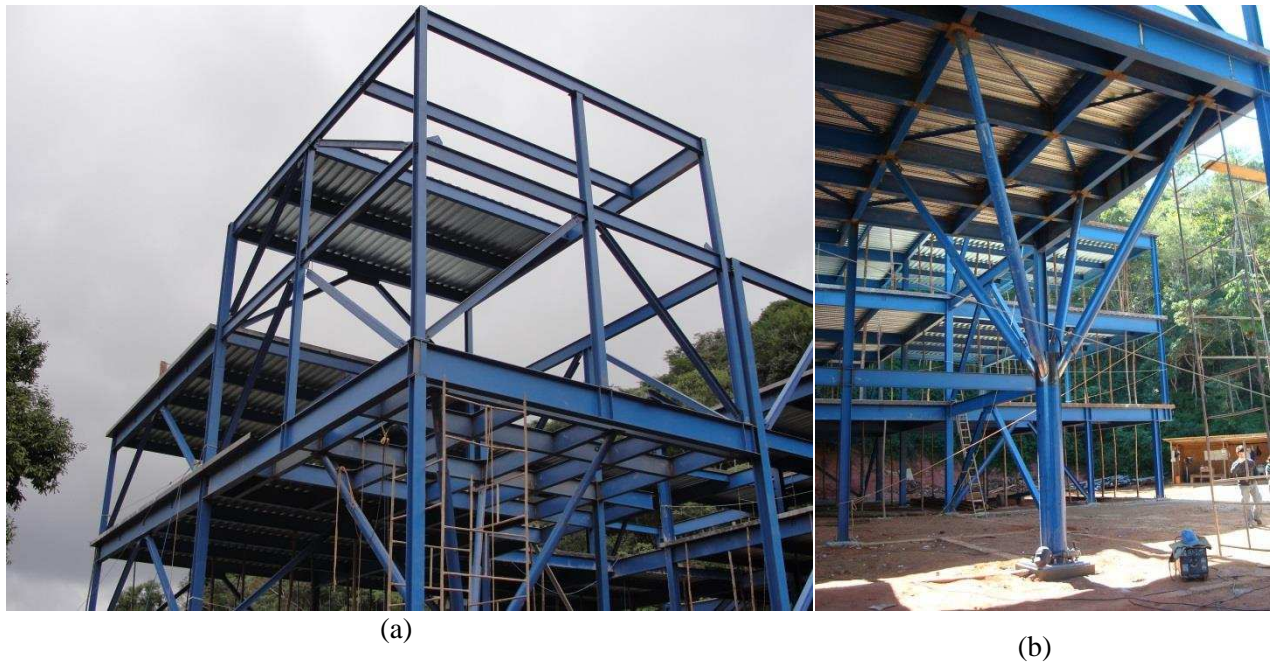
Figura 83 - Estrutura de aço do Edifício da CEAD.
