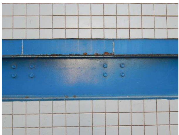
Figura 123 – Interface viga metálica – alvenaria, antes (a) e depois (b) da intervenção.
