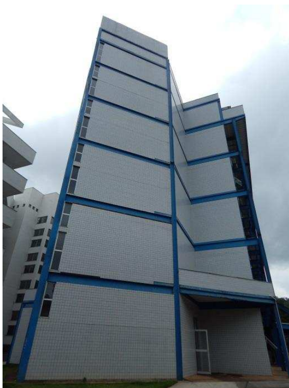
Figura 142 - Fachada da caixa de escada onde foi realizado o ensaio.
