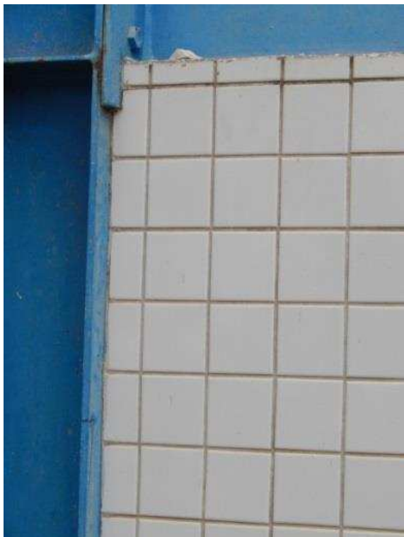
Figura 125 - Encontro alvenaria – mesa do perfil de aço, antes (a) e depois (b) da intervenção.
