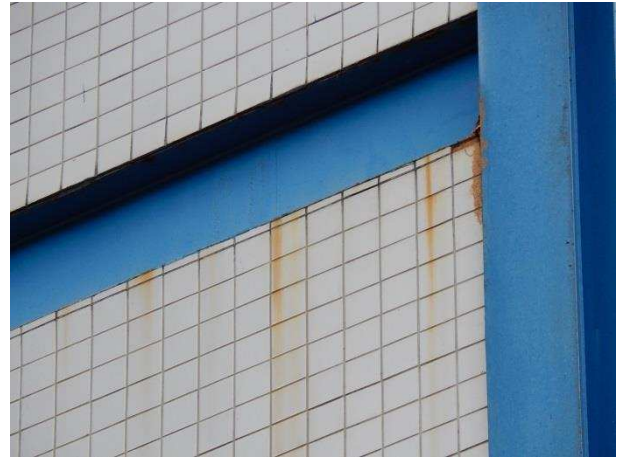
Figura 30- Alvenaria externa CCB-II/ UFV
