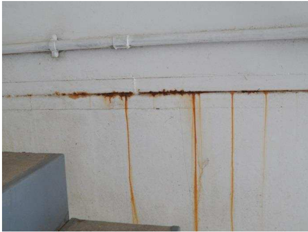
Figura 29- Alvenaria Interna CCB-II/ UFV
