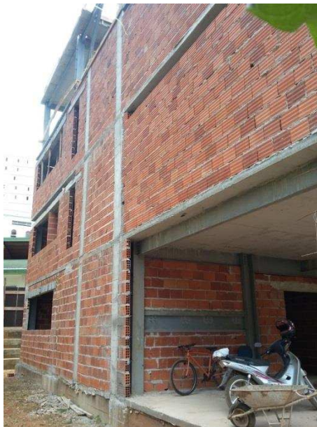
Figura 139 – Aspecto geral da alvenaria externa apoiada no balanço da laje maciça.
