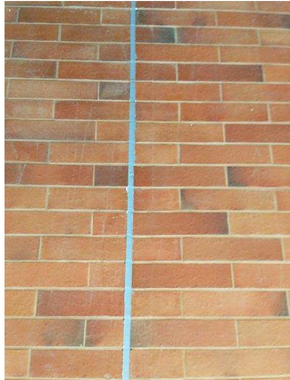
Figura 98 – Junta de movimentação vista na fachada do Edifício das Licenciaturas.
