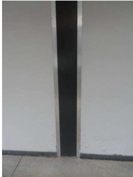
Figura 57 – Perfil de alumínio para acabamento de uma junta de movimentação em uma alvenaria interna do Edifício da Escola de Engenharia da UFMG.
