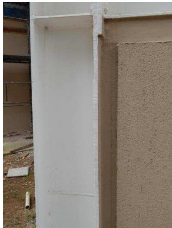
Figura 125 - Encontro alvenaria – mesa do perfil de aço, antes (a) e depois (b) da intervenção.
