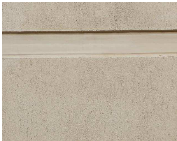
Figura 122 – Local da junção dos painéis de CCA, antes (a) e depois (b) da intervenção.
