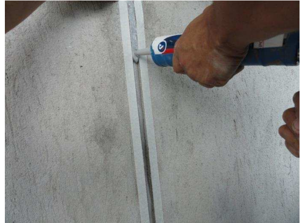
Figura 15 - Aplicação do mastique na junta de movimentação.
