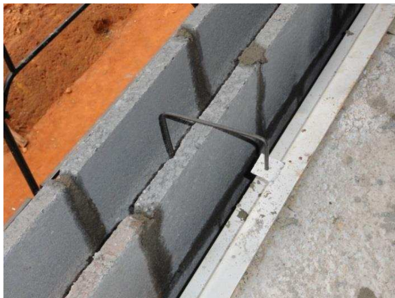
Figura 79 - Execução do dispositivo de ligação laje-alvenaria externa.
