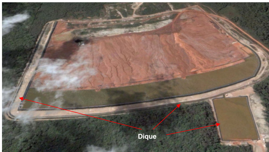
Figura 1.1 – Dique de rejeitos da empresa Rio Capim Caulim, em Barcarena-PA.
